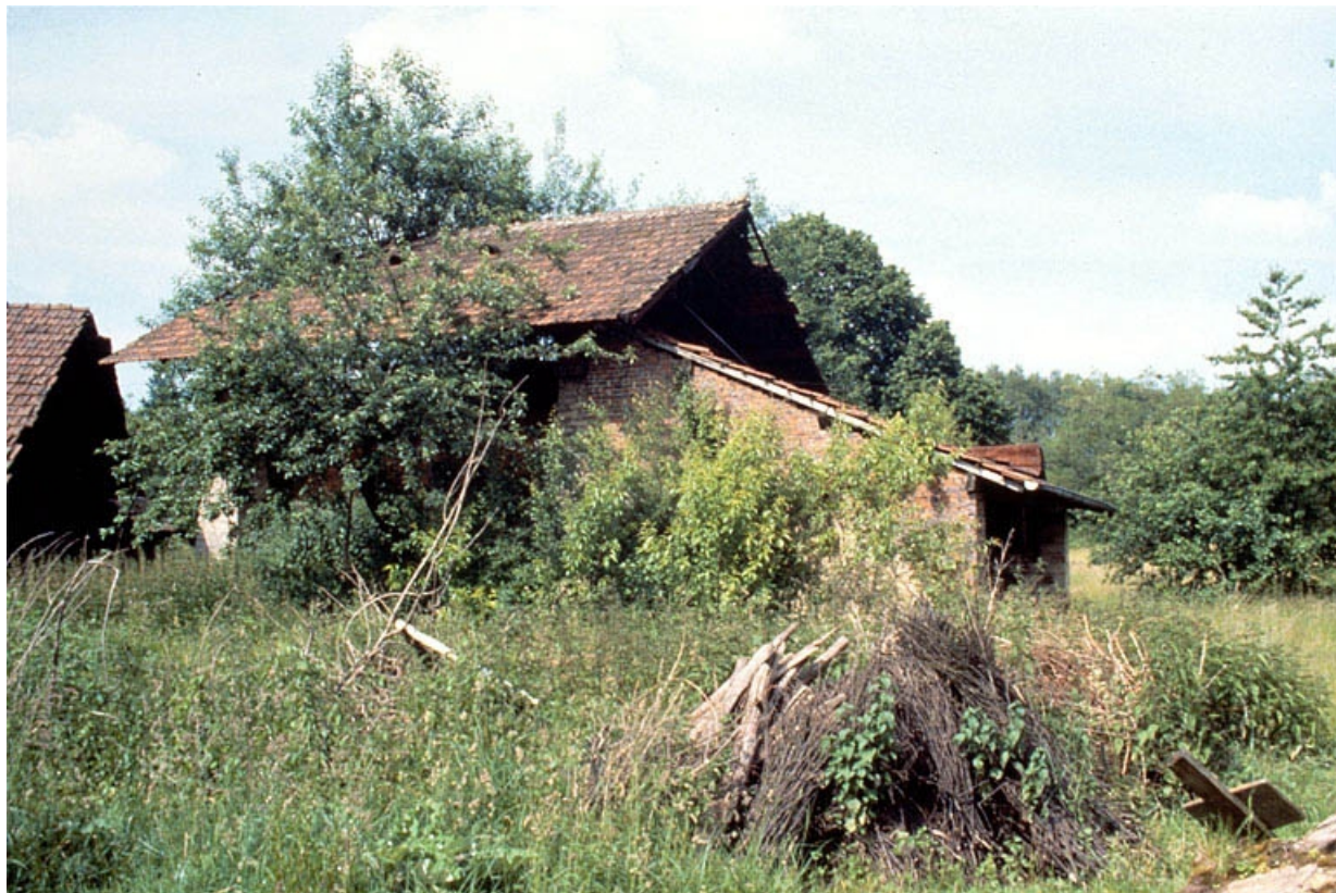
Bâtiment du four (C), depuis le sud.
