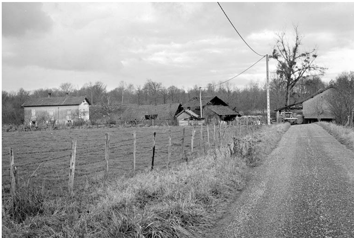
Logement patronal (A), atelier de fabrication et pièce de séchage (B), et bâtiment du four (C). 39, Santans, lieudit : la Vigne
