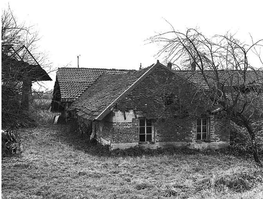
Atelier de fabrication et pièce de séchage : détail de l'aile en retour au nord.
