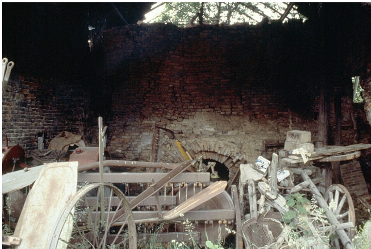
Bâtiment du four : foyer au centre, cendrier à droite.
