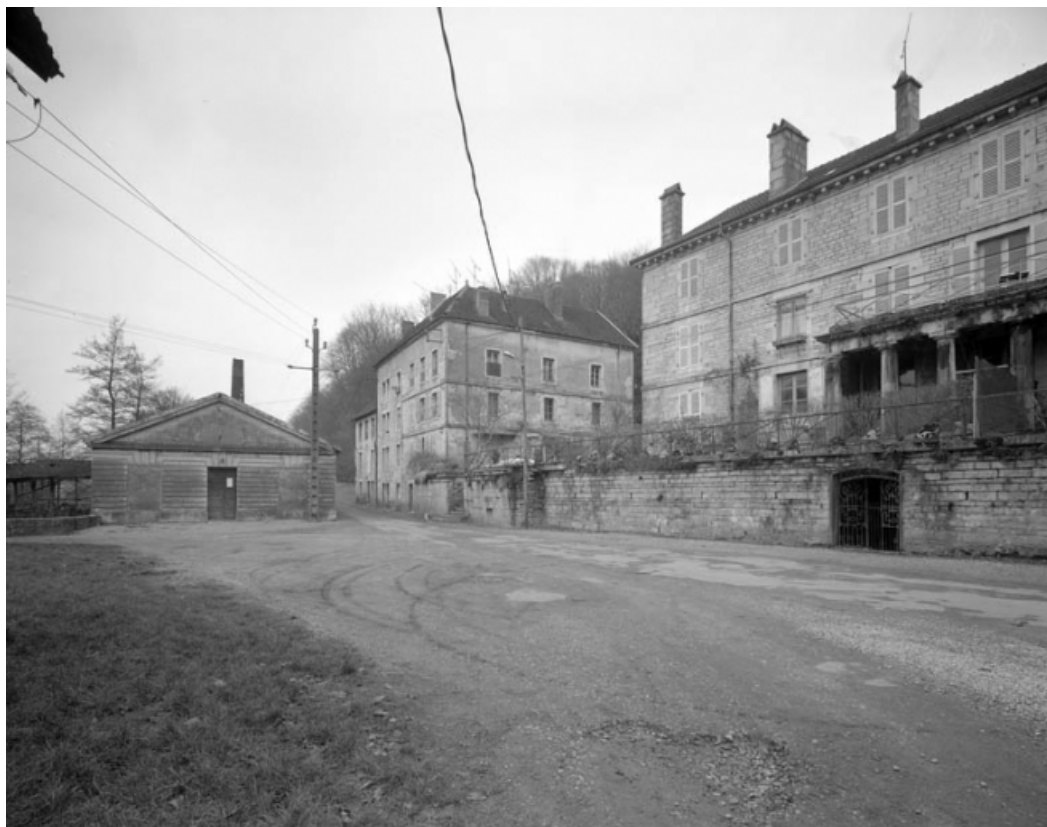
Vue d'ensemble : Sénat, logement de contremaître et Gérance.
