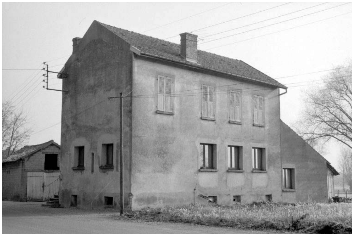
Façade postérieure du bâtiment principal et de l'ancienne remise (B).
