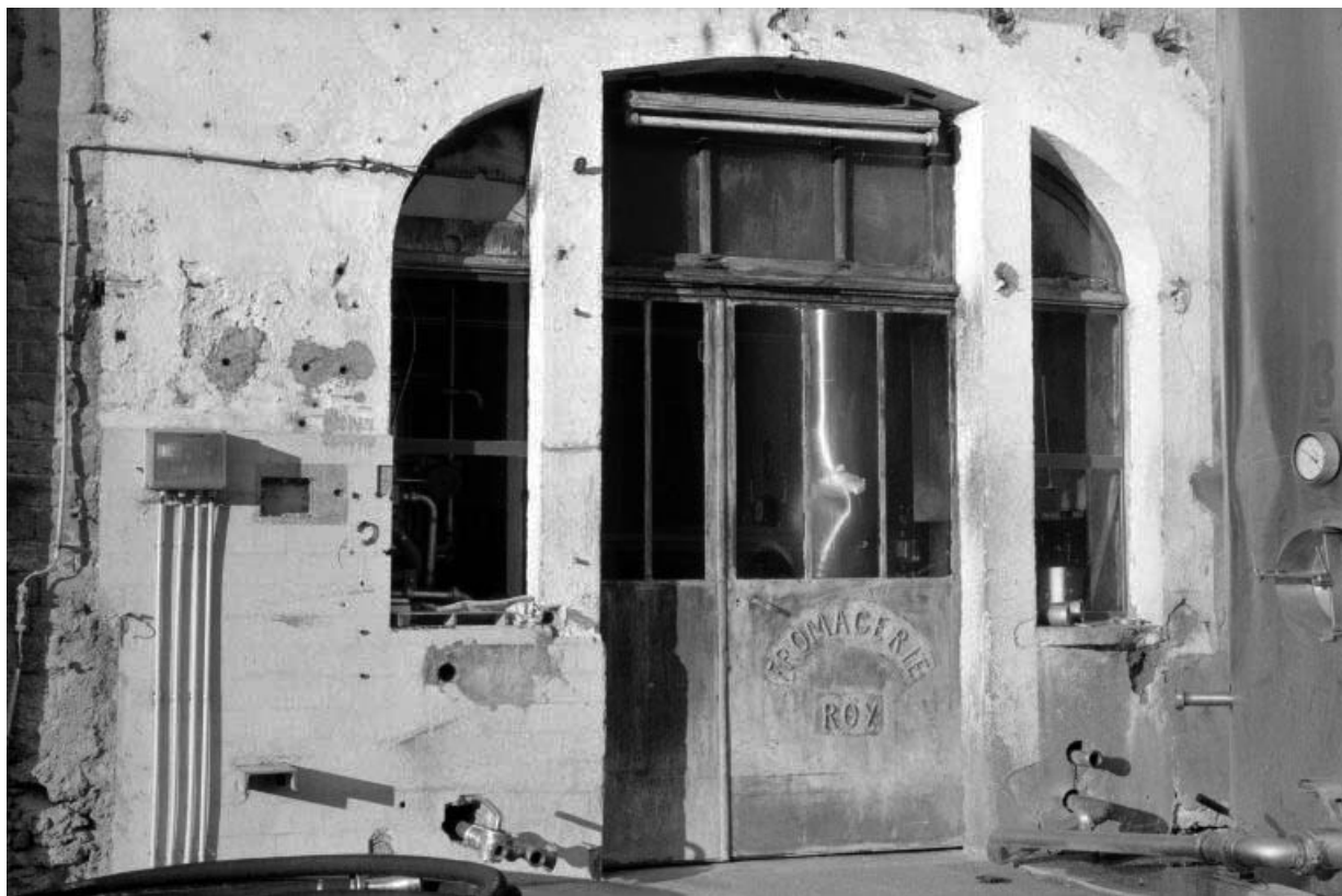
Porte d'entrée de l'atelier de fabrication.
