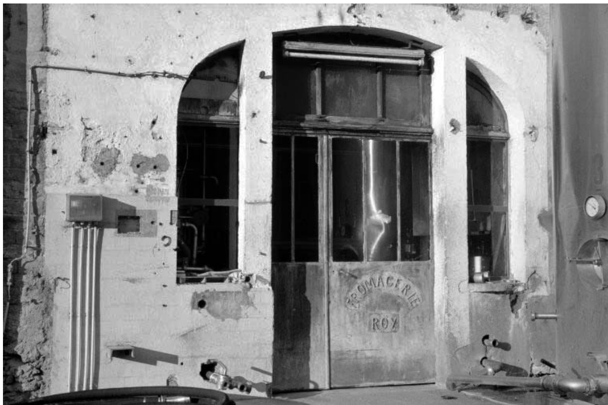
Porte d'entrée de l'atelier de fabrication.
