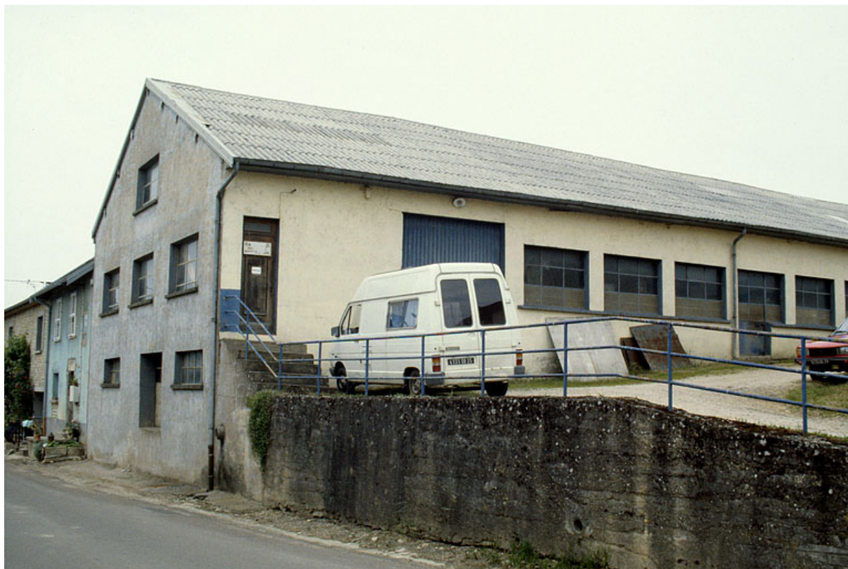
Atelier de fabrication (B), vu de trois quarts gauche. À l'étage de soubassement, porte de chargement donnant sur le magasin. 39, La Barre
