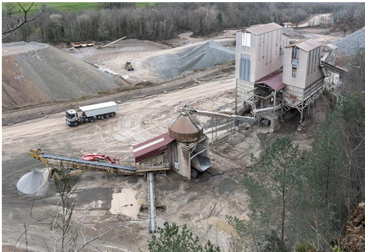
Vue d'ensemble plongeante sur les nouvelles installations de concassage, avec camion.
