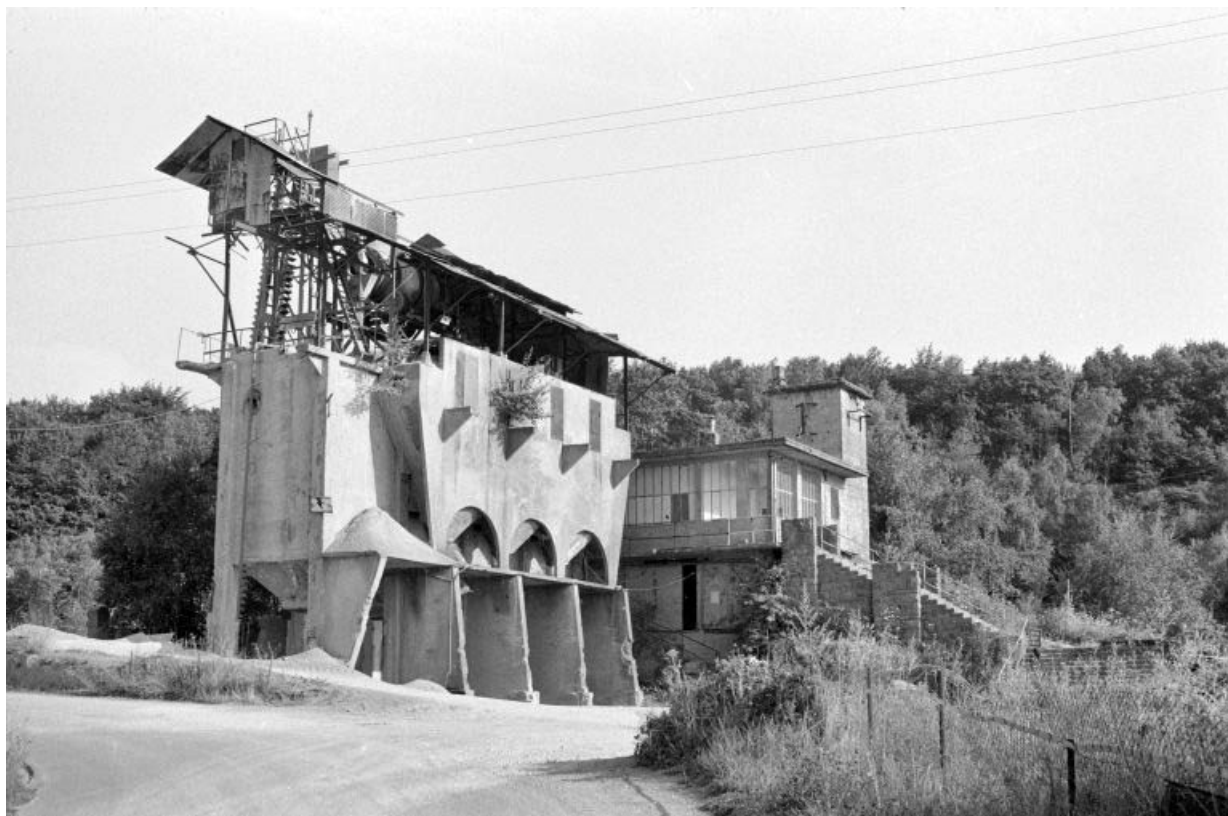
Poste de lavage (C) et poste de surveillance (D) vus depuis le nord.
