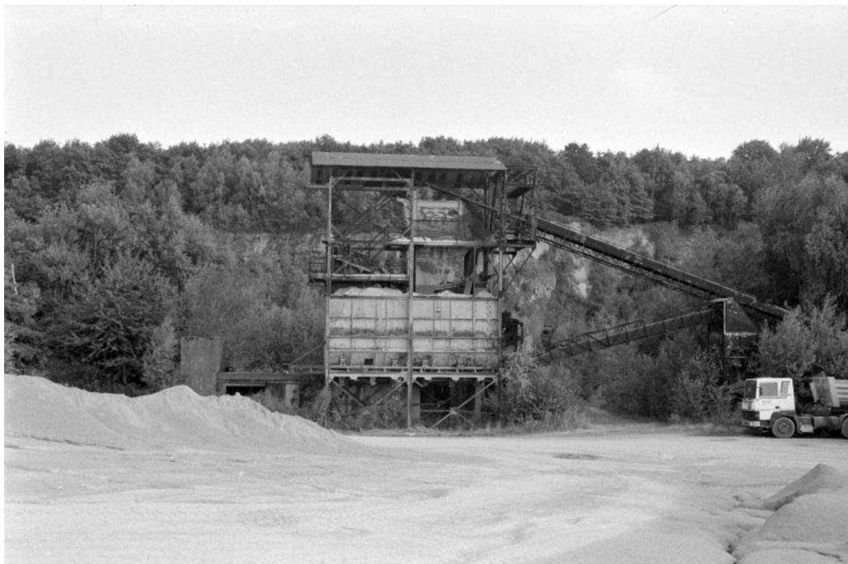
Anciennes installations vues du nord-ouest : poste de concassage (I).
