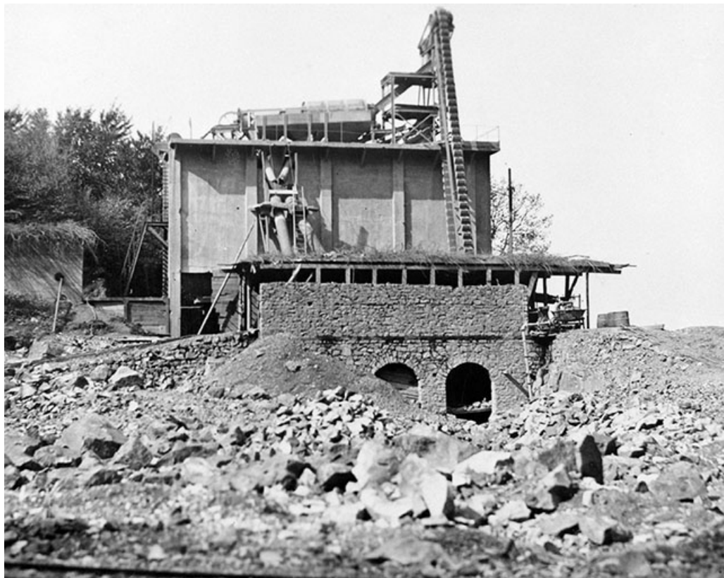
Poste de concassage (C) vu de l'est. 39, Moisey, lieudit : Bois de la Serre
