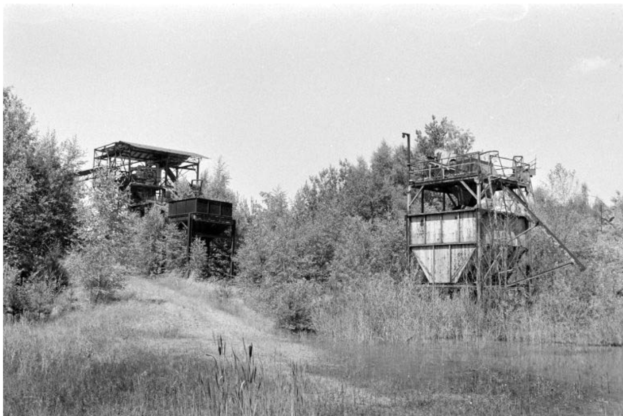
Anciennes installations : trémie et poste de concassage (I).
