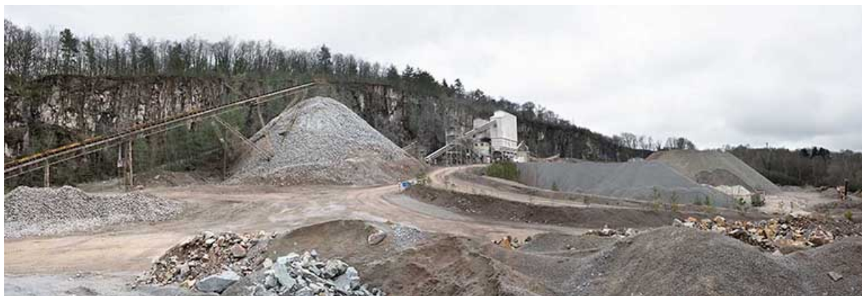
Vue d'ensemble des nouvelles installations, depuis le nord-est.
