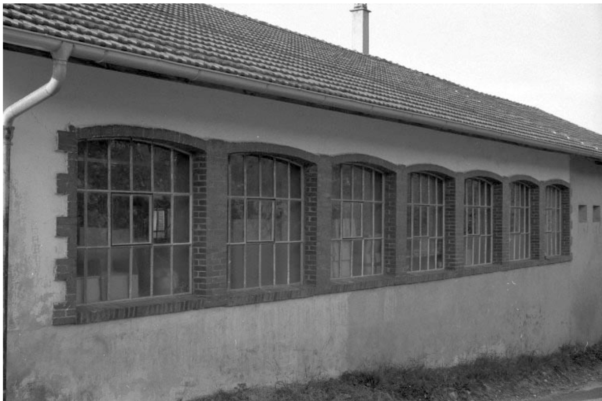
Fenêtres de la façade latérale droite.
