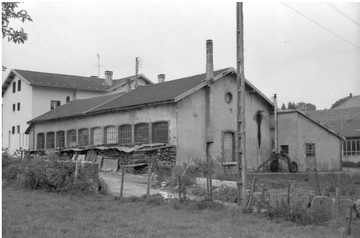
Façades postérieure et latérale gauche du second bâtiment.
