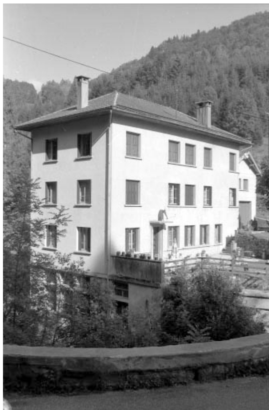
Logement patronal vu de trois quarts gauche. Atelier en soubassement.
