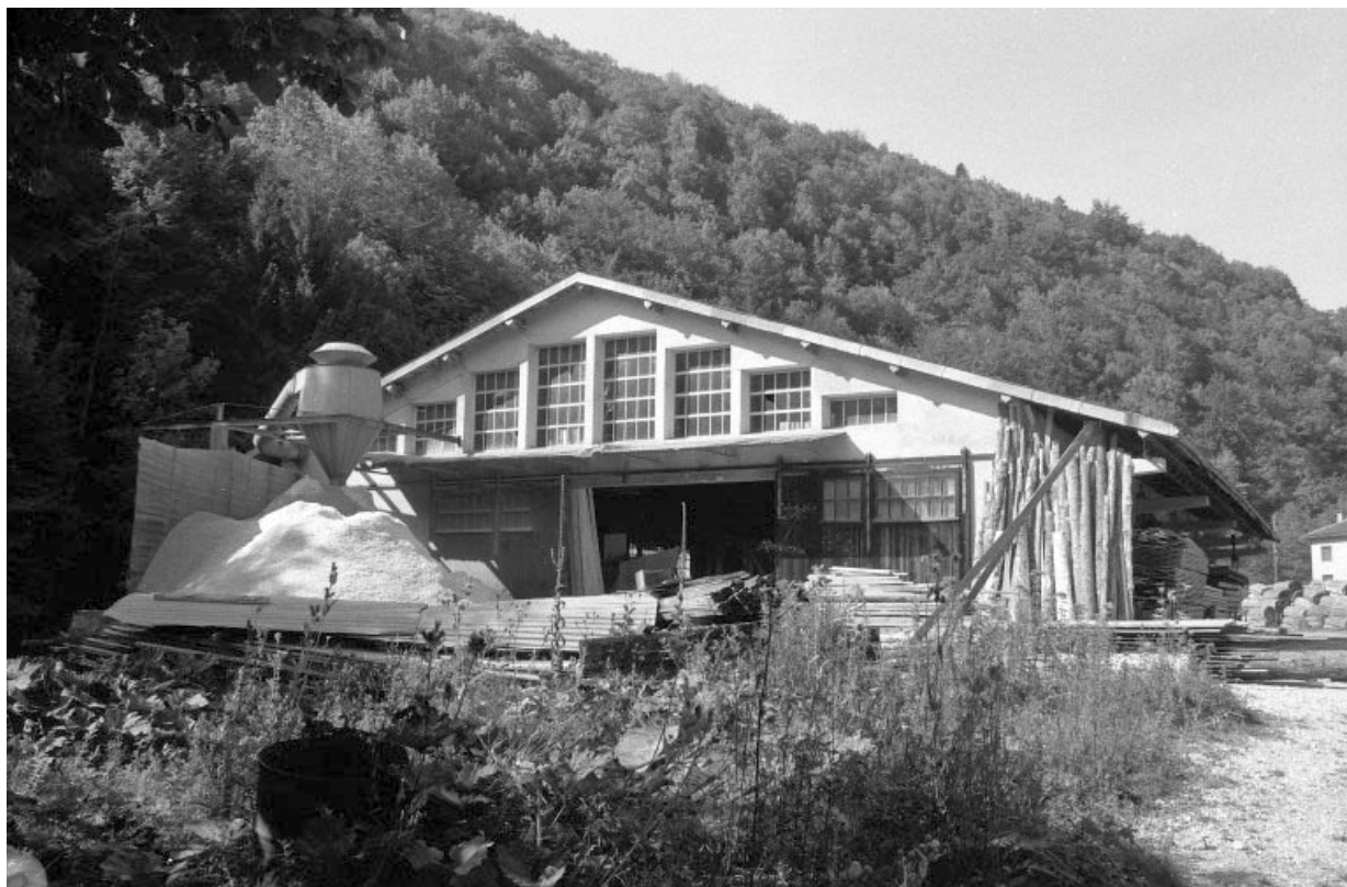
Façade postérieure de la scierie.
