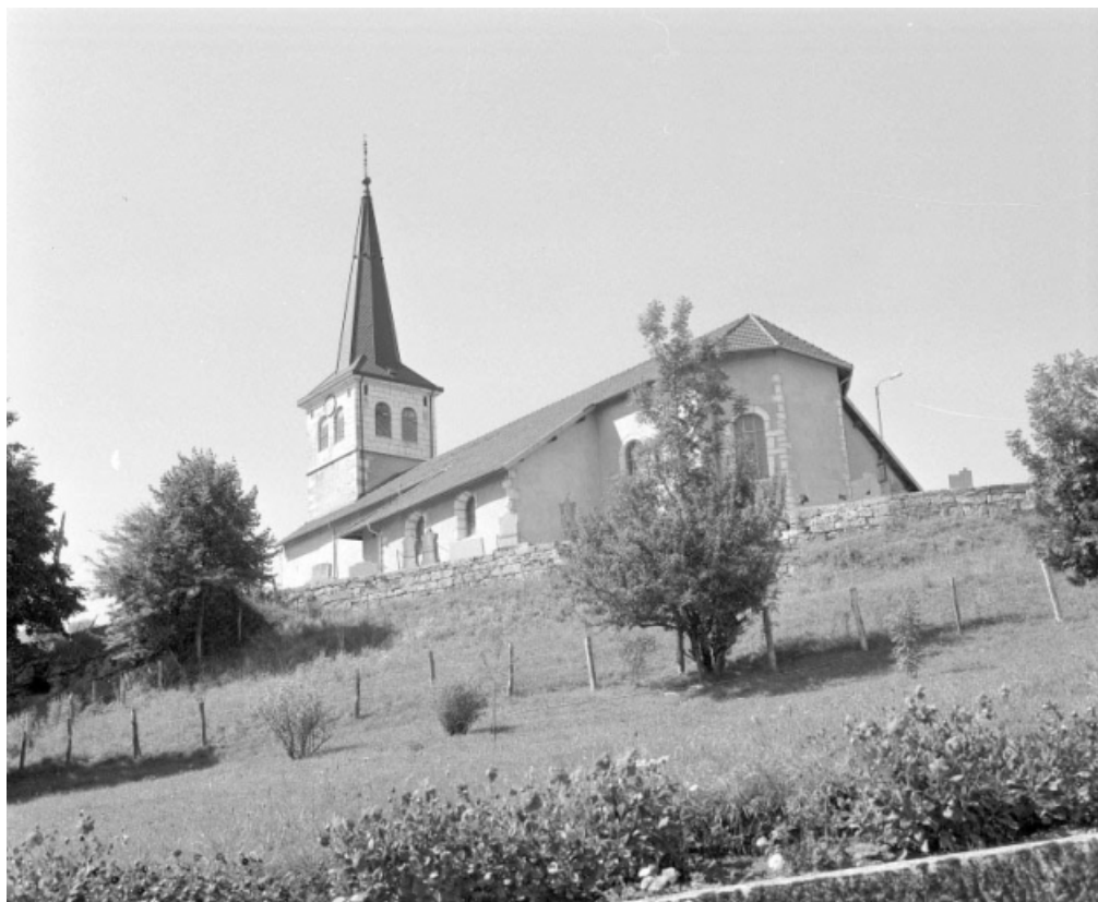
Extérieur : vue générale depuis le sud-est.
