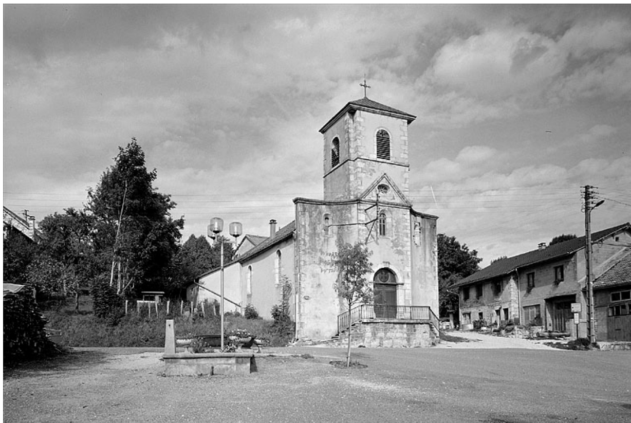
Extérieur : façade ouest et face sud.
