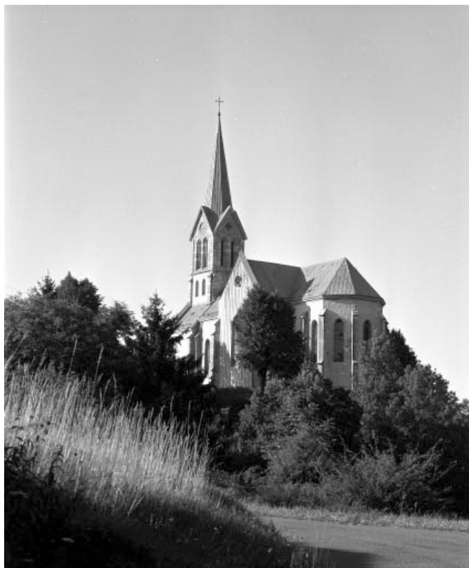
Extérieur : abside et face sud.
