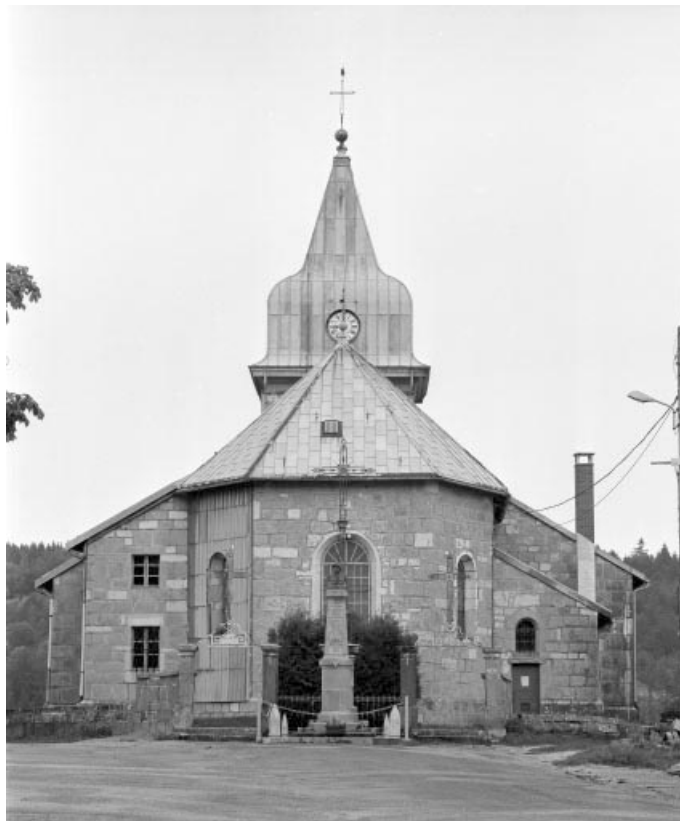
Extérieur : l'abside, vue de face.
