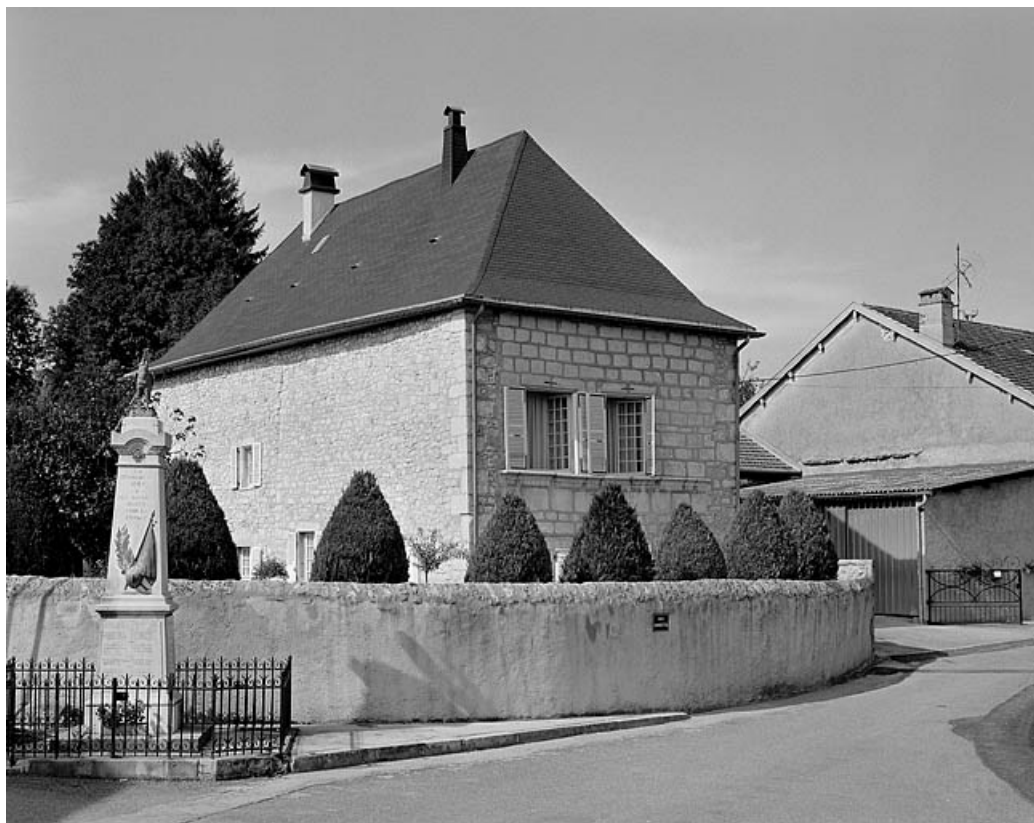
Vue générale depuis la rue Gambetta. 39, Viry
