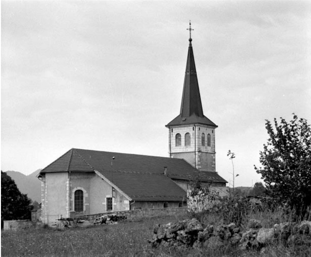
Extérieur : vue générale depuis le nord-est.
