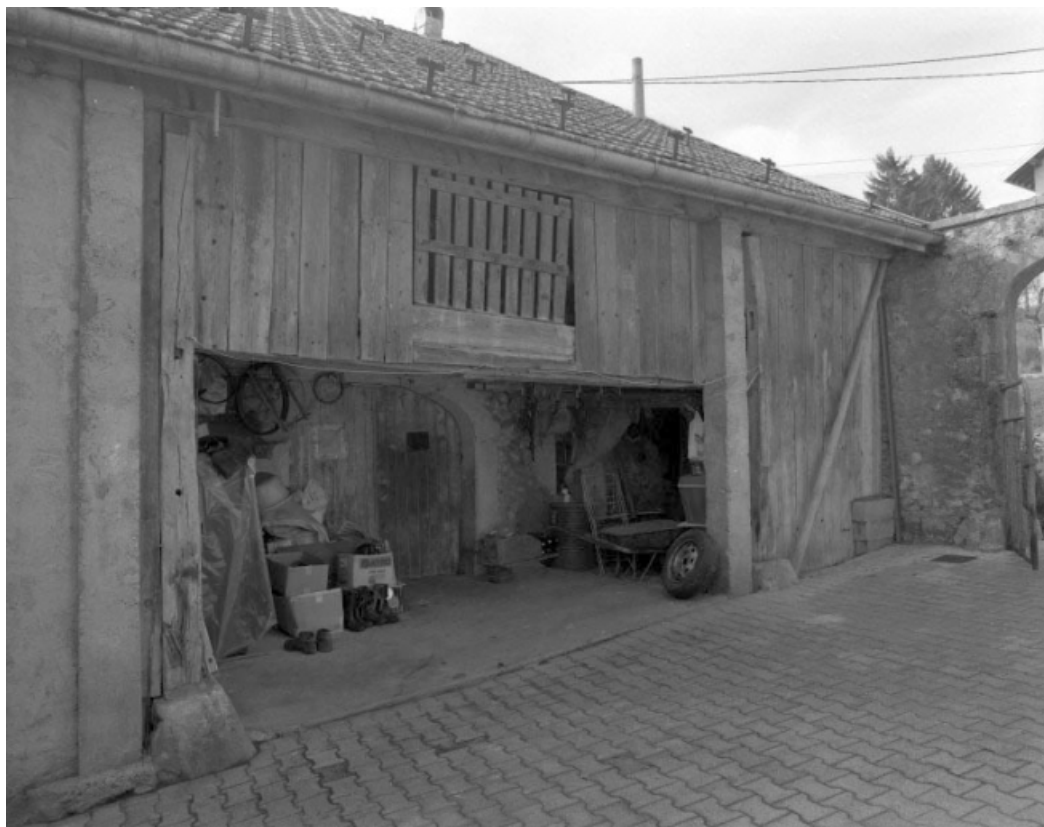
Accès à l'étable depuis la cour.
