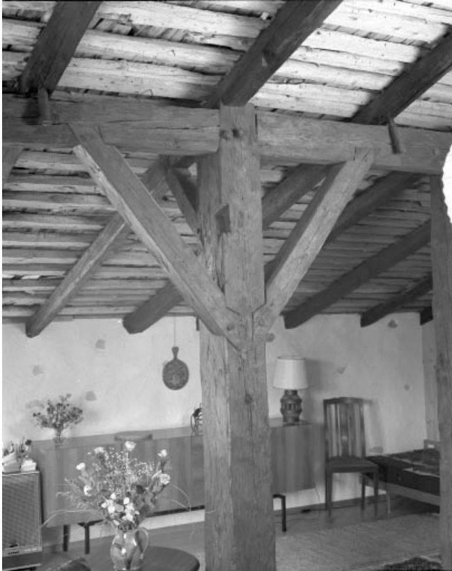
Détail de la charpente : assemblage d'un poteau avec la panne. Il manque une contre fiche dans le plan parallèle à la pente du toit. 39, Les Moussières, lieudit : au Montechoux
