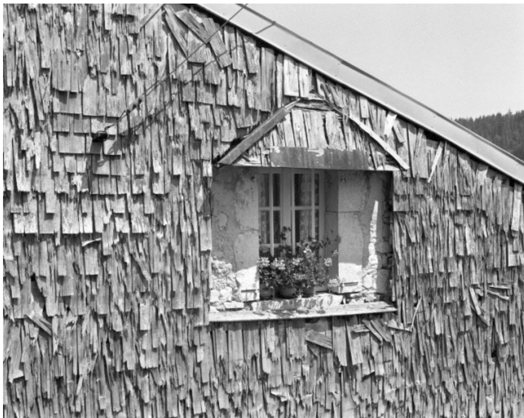
La fenêtre de la face gauche.
