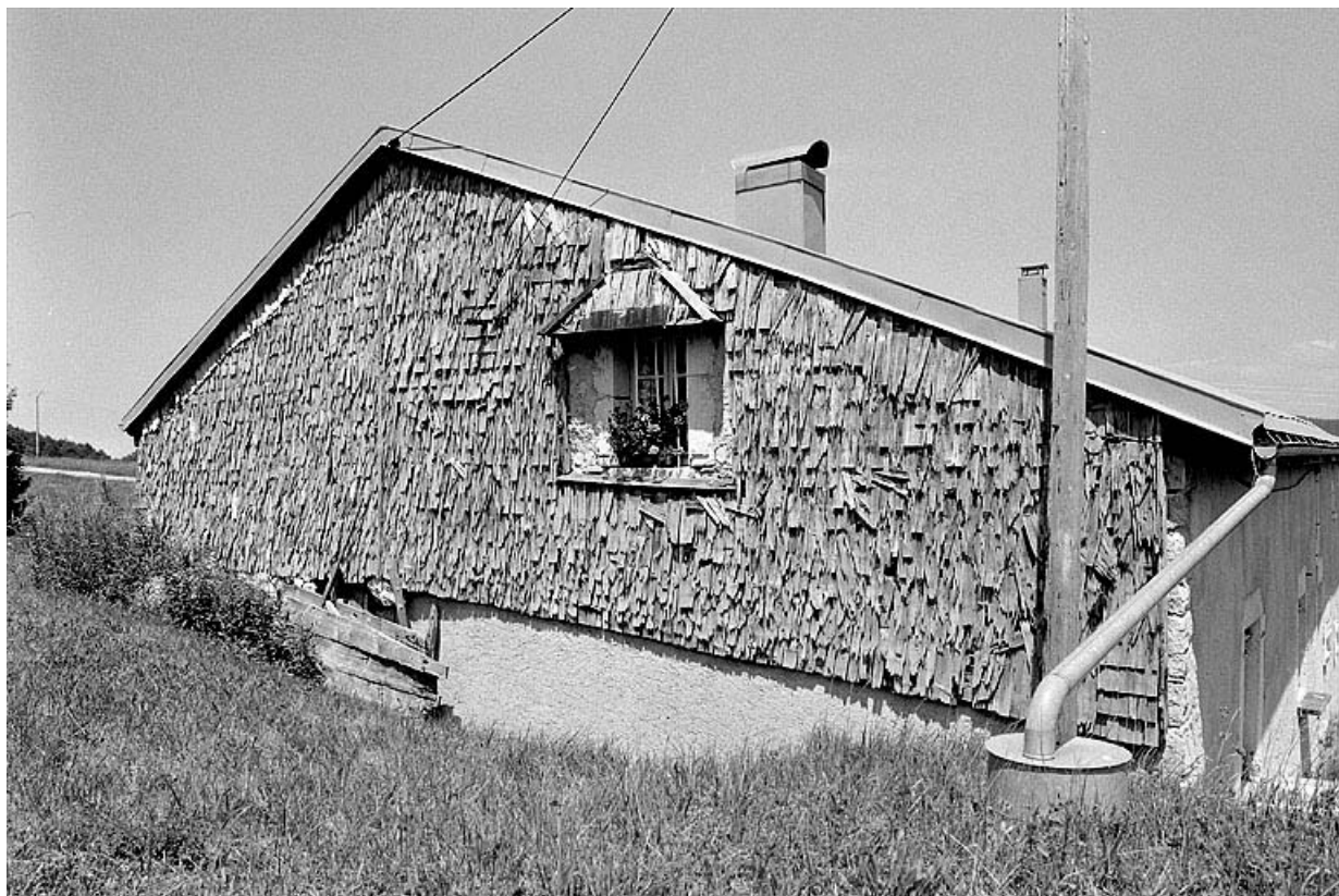
Face gauche couverte d'un essentage de tavaillons.
