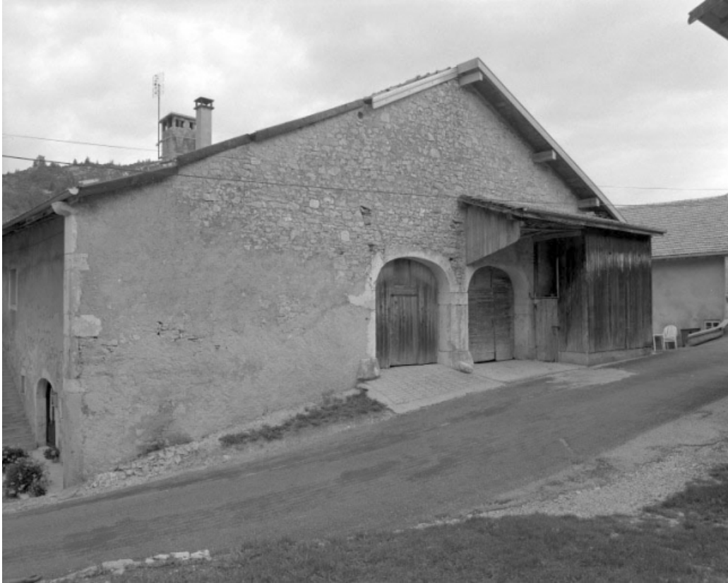
Face droite et accès aux deux granges hautes.
