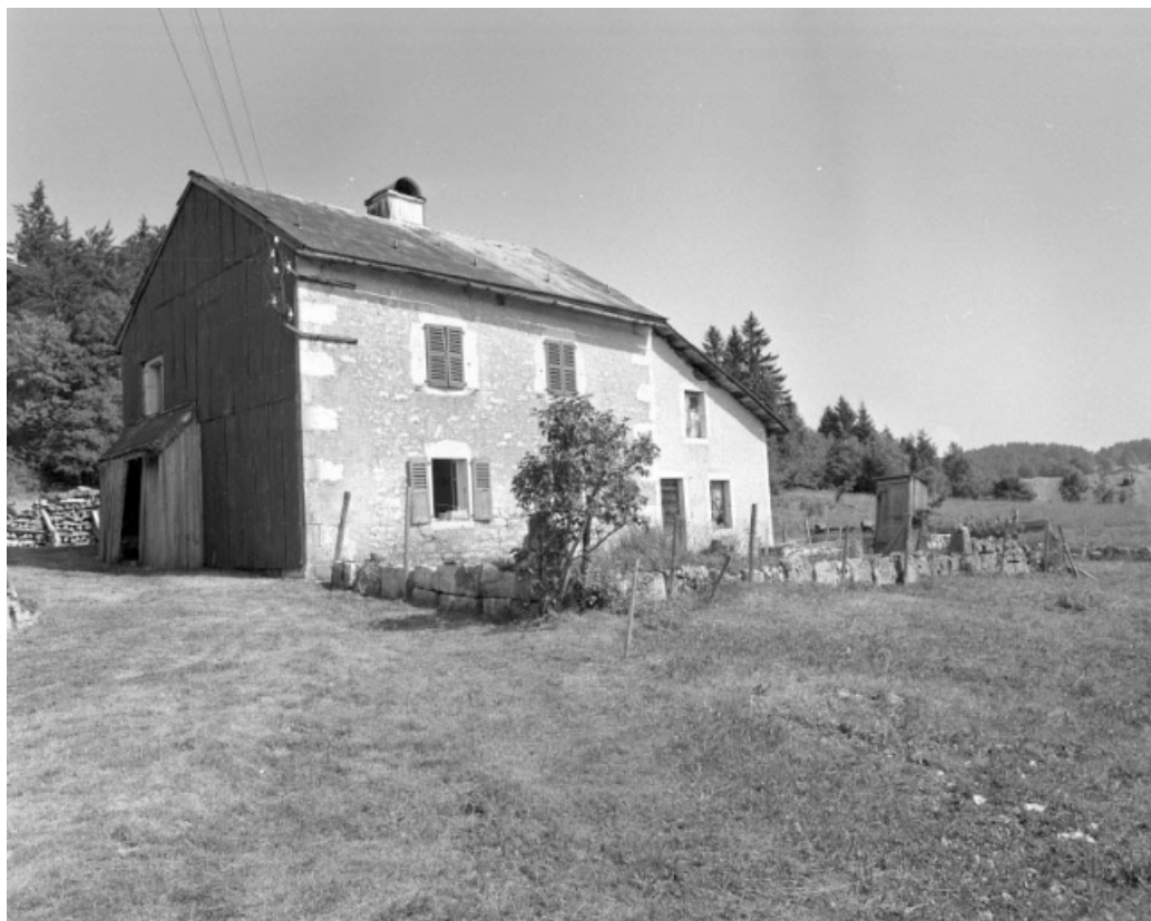
Façade antérieure et face gauche de la maison de douaniers.
