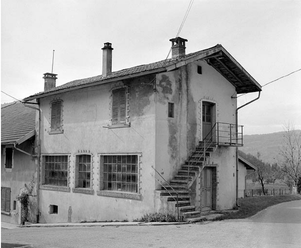
Façade longitudinale et pignon.
