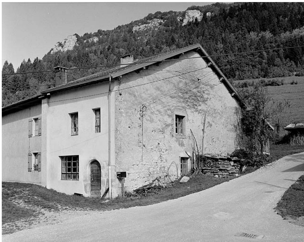
Façade antérieure et face droite.
