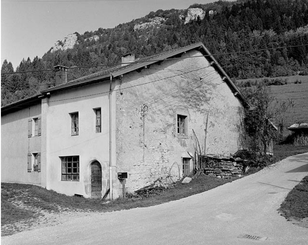
Façade antérieure et face droite.
