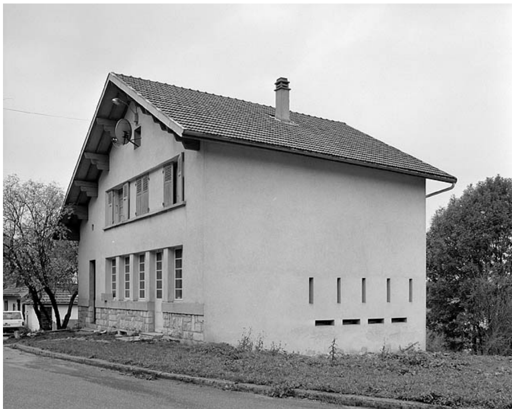
Façade antérieure et face droite.
