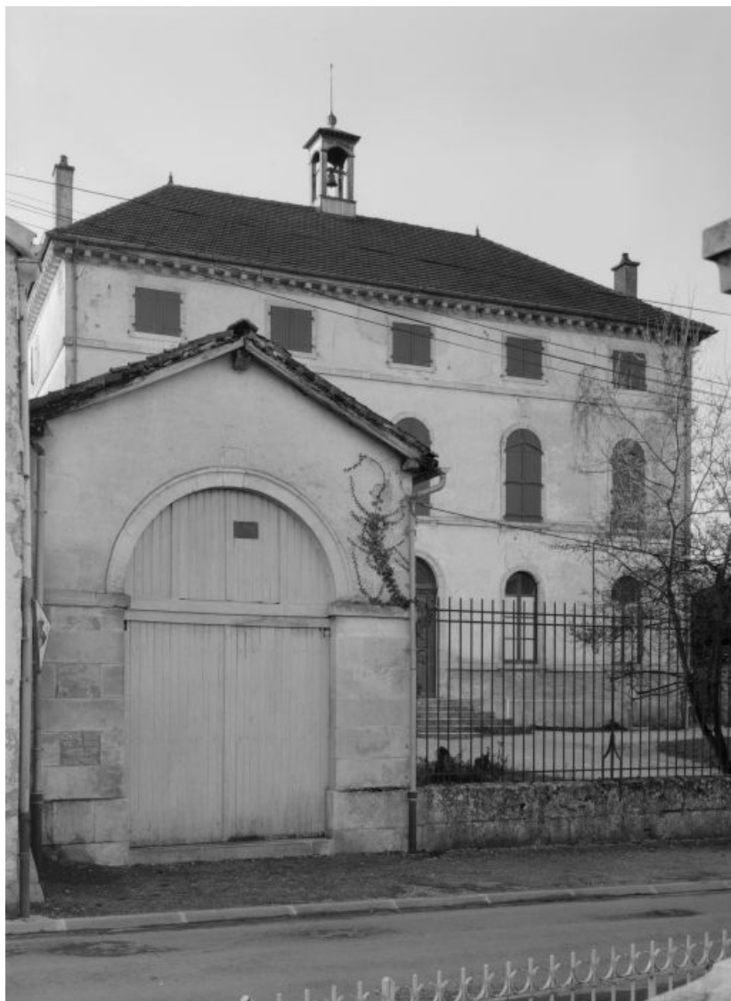
Vue de la maison et du bâtiment de dépendance situé à gauche de la grille. 21, Aisey-sur-Seine, 10 Grande Rue
