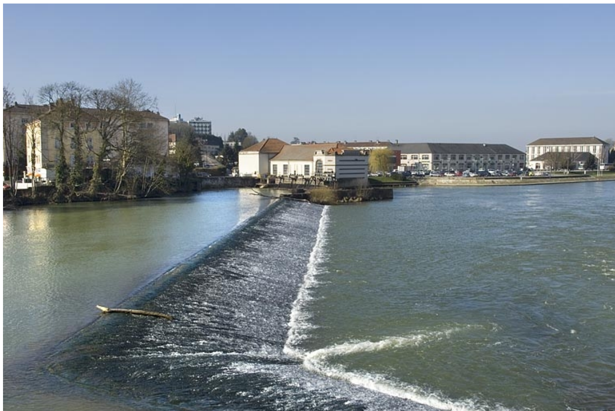
Le barrage depuis la rive droite de la Saône. 70, Gray
