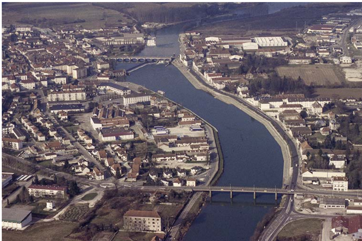
Vue aérienne de la ville basse et des deux ponts. 70, Gray
