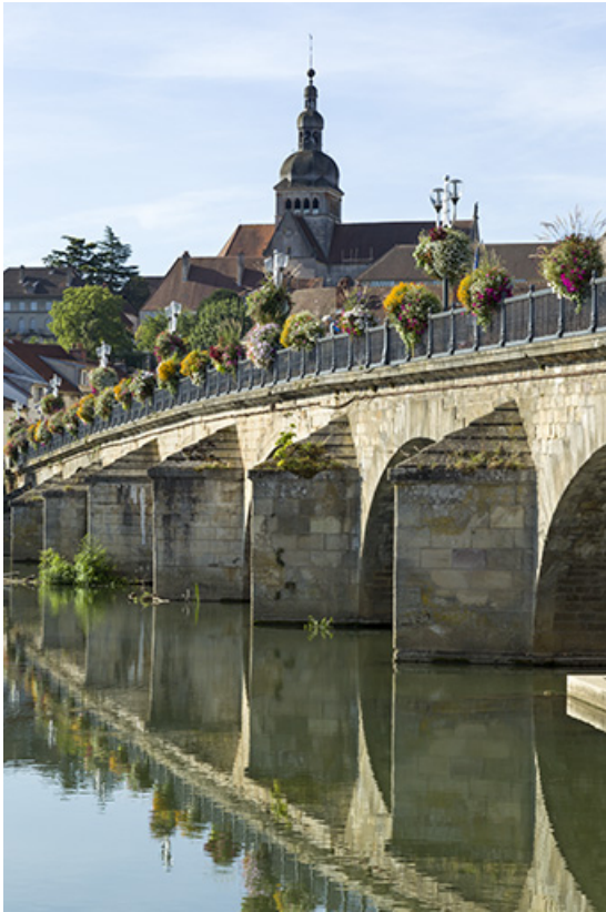
Détail des avant-bec des piles.
