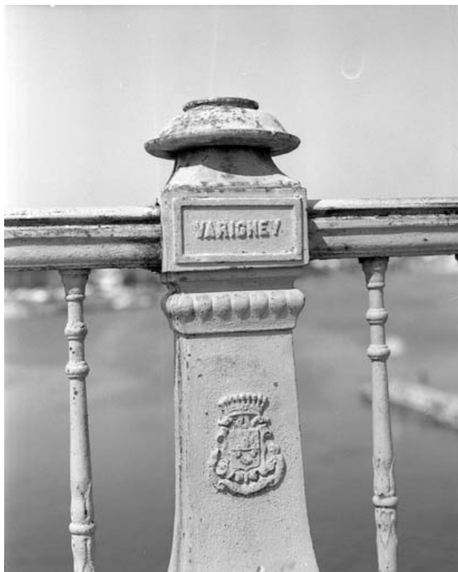
Détail du garde-corps : vue de l'inscription et du blason de la ville de Gray sur le balustre central. 70, Gray
