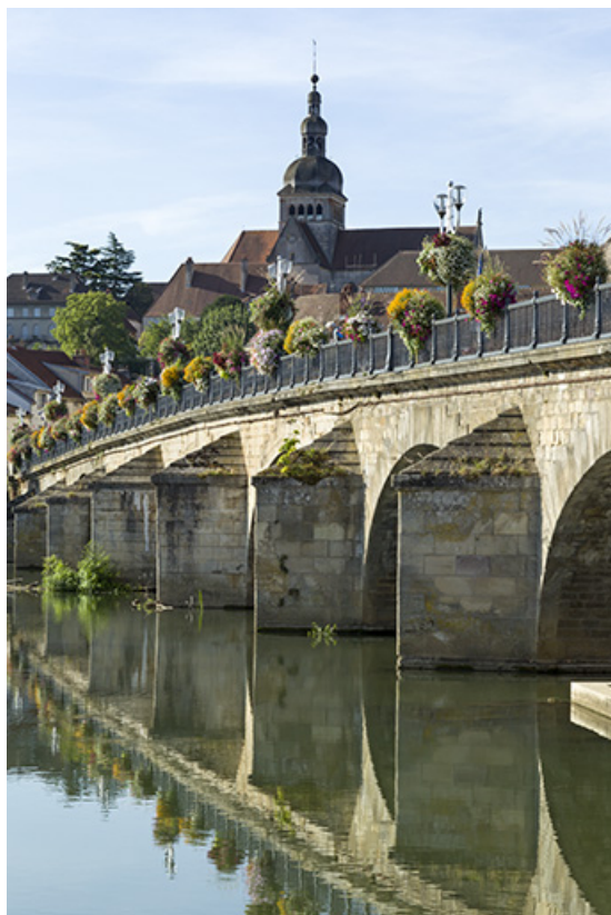
Détail des avant-bec des piles.
