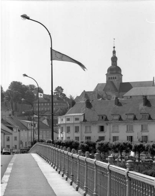
Vue du garde-corps en fonte.
