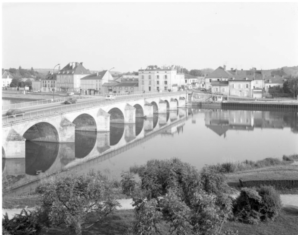
Vue d'ensemble depuis la ville basse. 70, Gray
