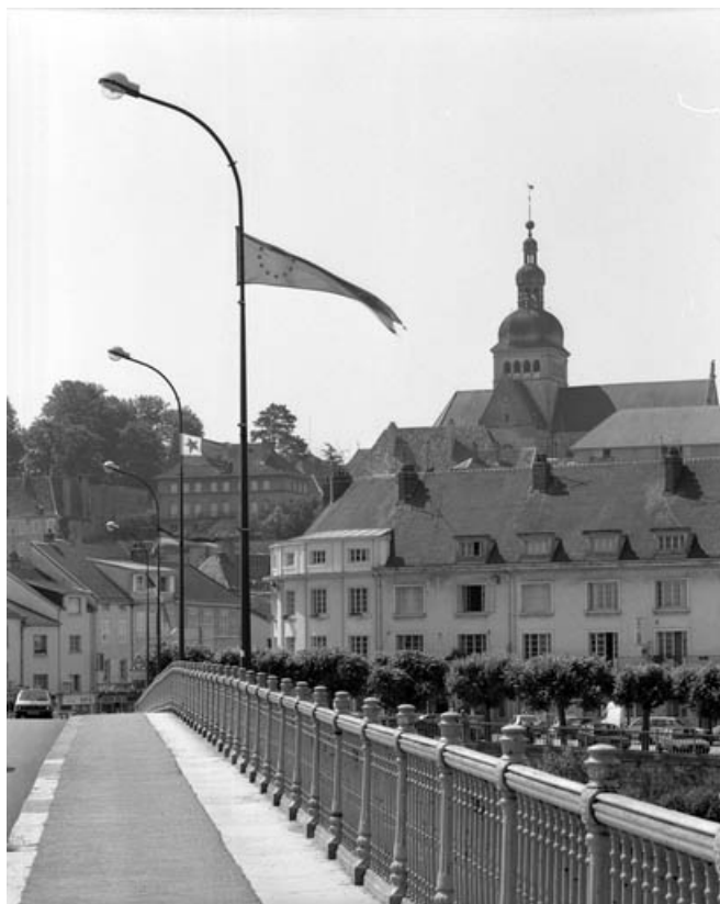
Vue du garde-corps en fonte.
