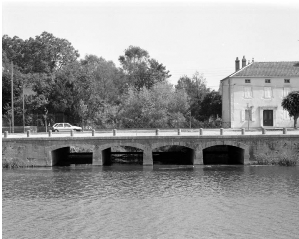
Vue d'ensemble, de face.
