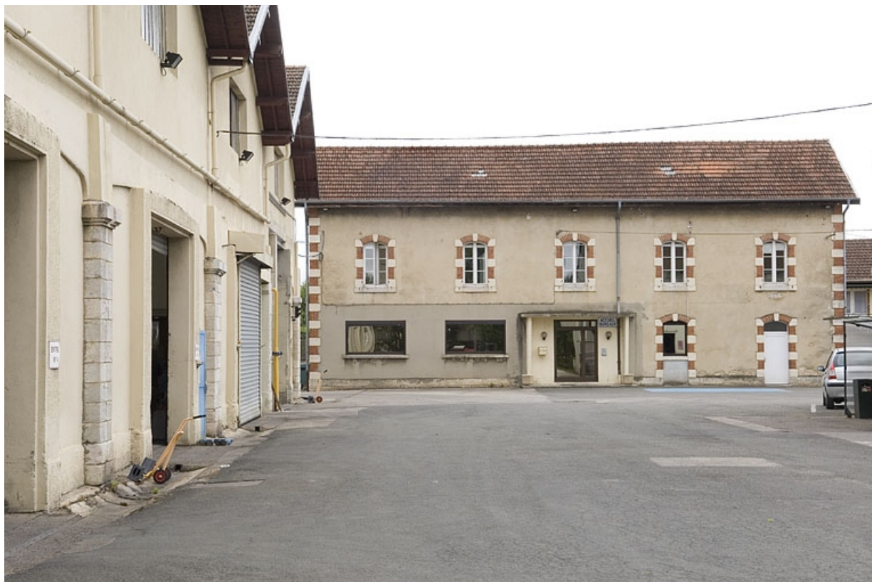
Atelier de fabrication et bureaux depuis la cour.
