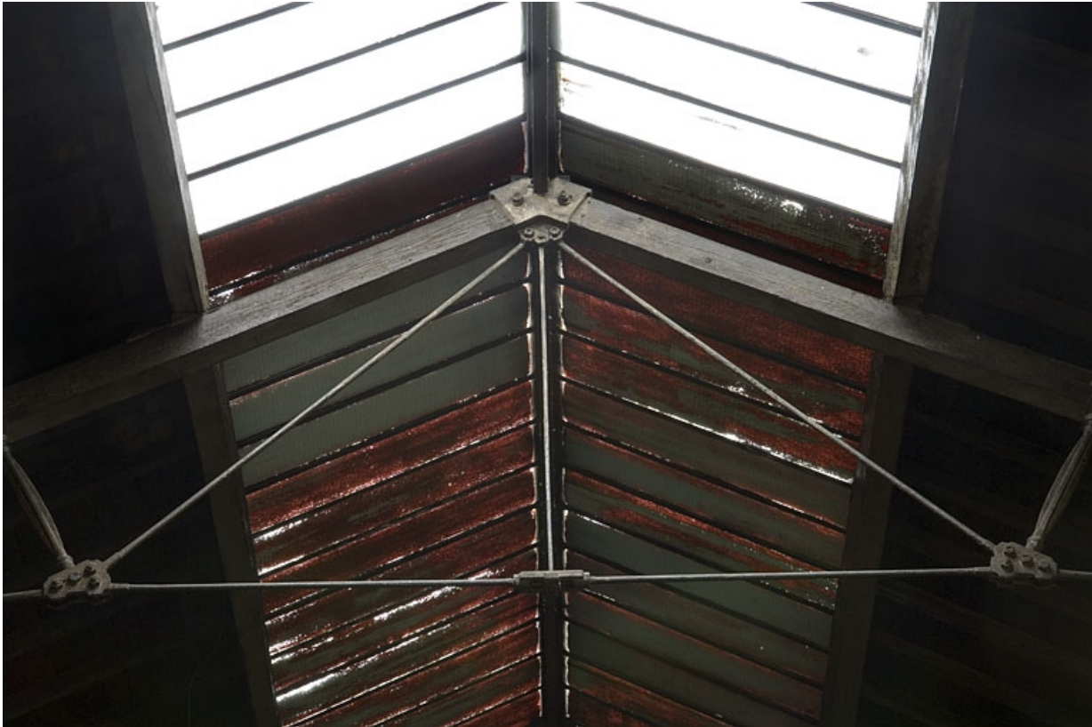
Détail de la charpente Polonceau de l'atelier.
