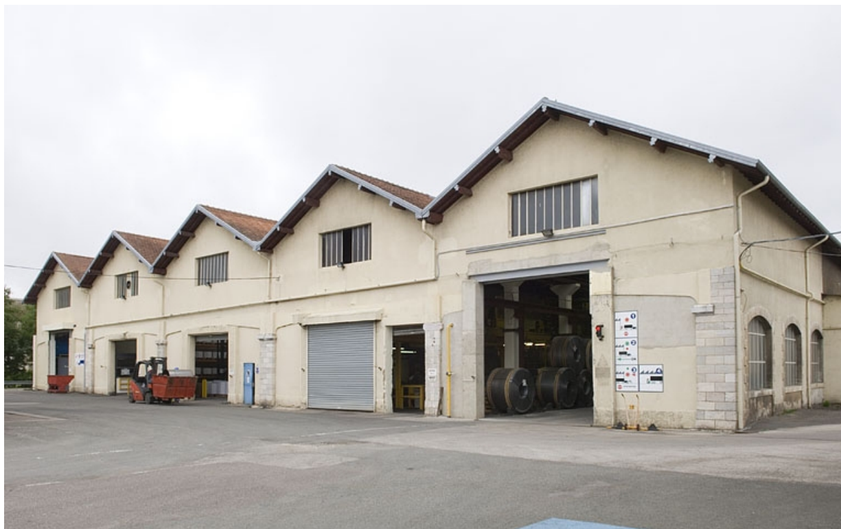
Atelier de fabrication (ancien atelier des locomotives).
