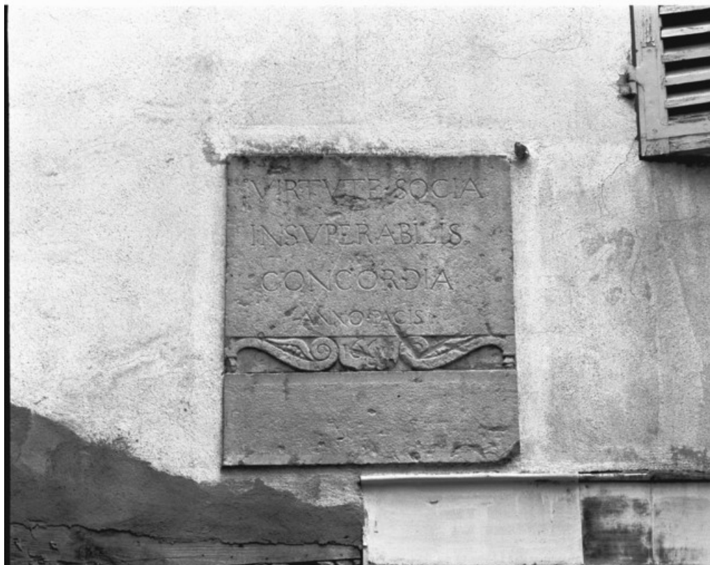
Détail d'une inscription sur la façade postérieure de l'imprimerie. 70, Gray Grande Rue 47
