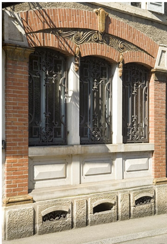
Détail d'une baie triple.
