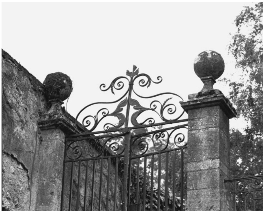
Détail de la partie supérieure de la grille du jardin.
