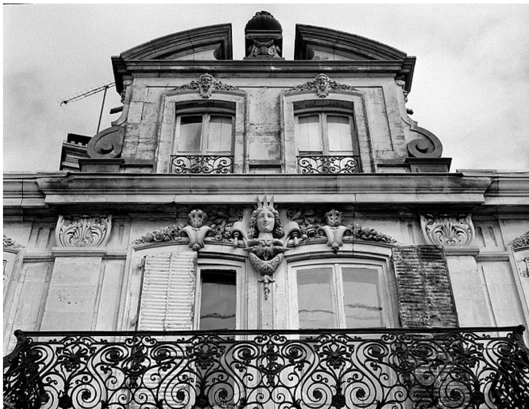
Façade antérieure de l'habitation. Détail du premier étage et du couronnement en 1988. 70, Gray, 12 quai Villeneuve
