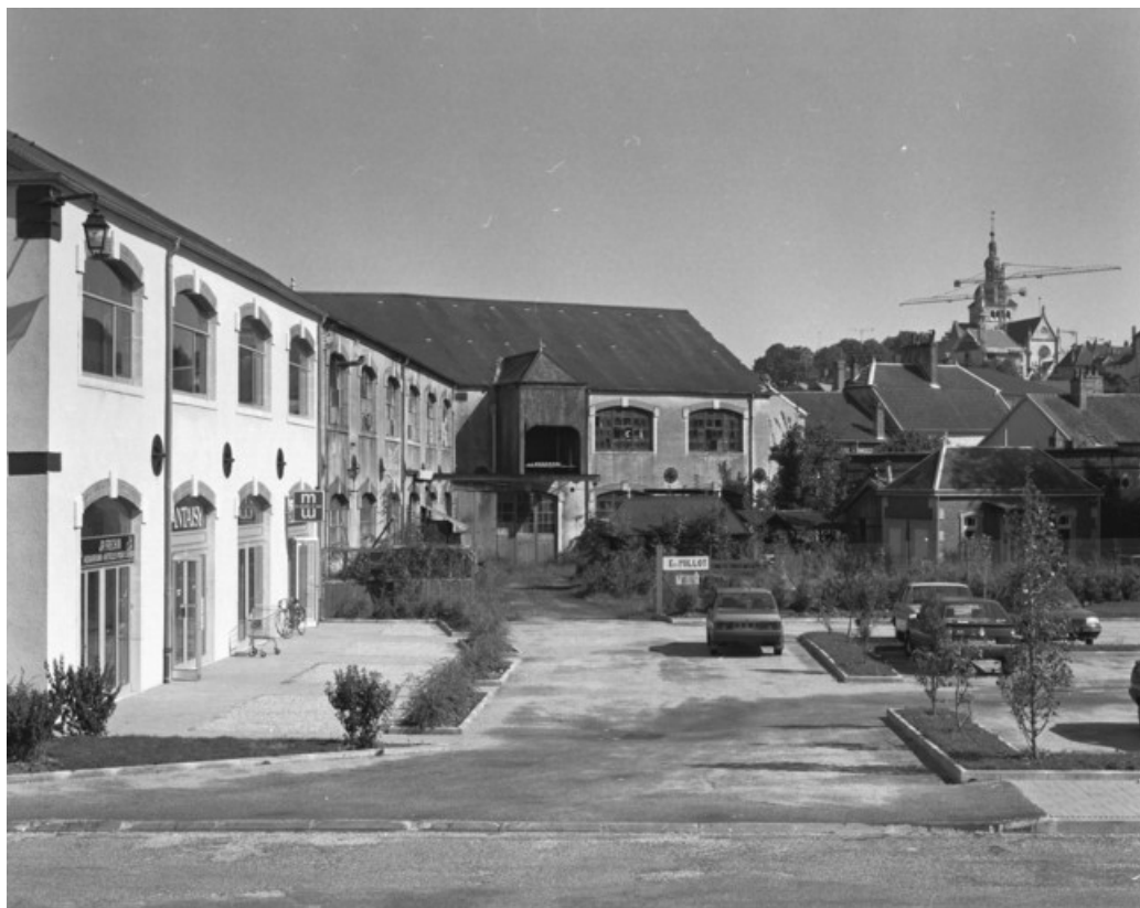
Façade postérieure de l'atelier d'ajustage, de montage et de peinture. Vue de trois quarts en 1988. 70, Gray, 5, 7 quai Mavia
