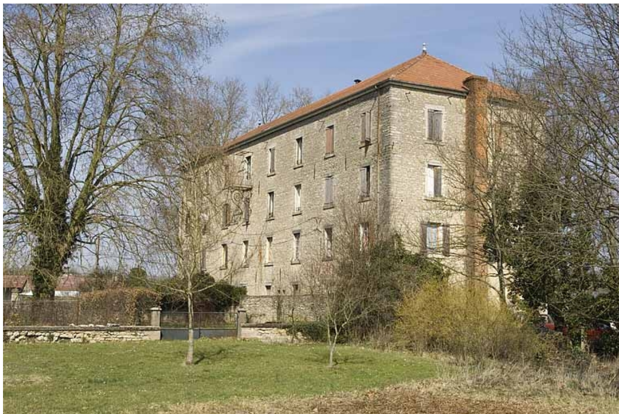
Vue depuis le sud-ouest.
