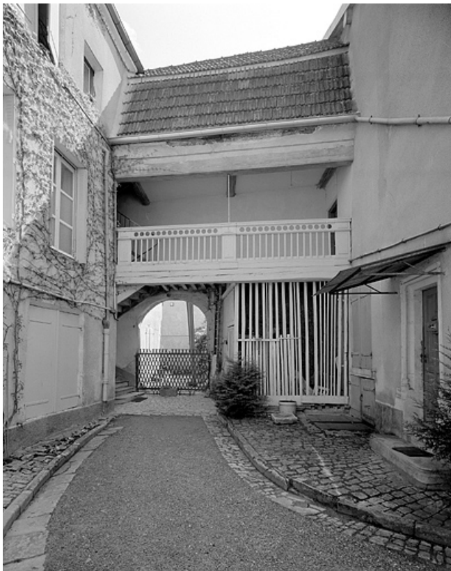
Détail : galerie de liaison entre logement gauche sur cour et bâtiment sur rue. 70, Gray Grande Rue 61
