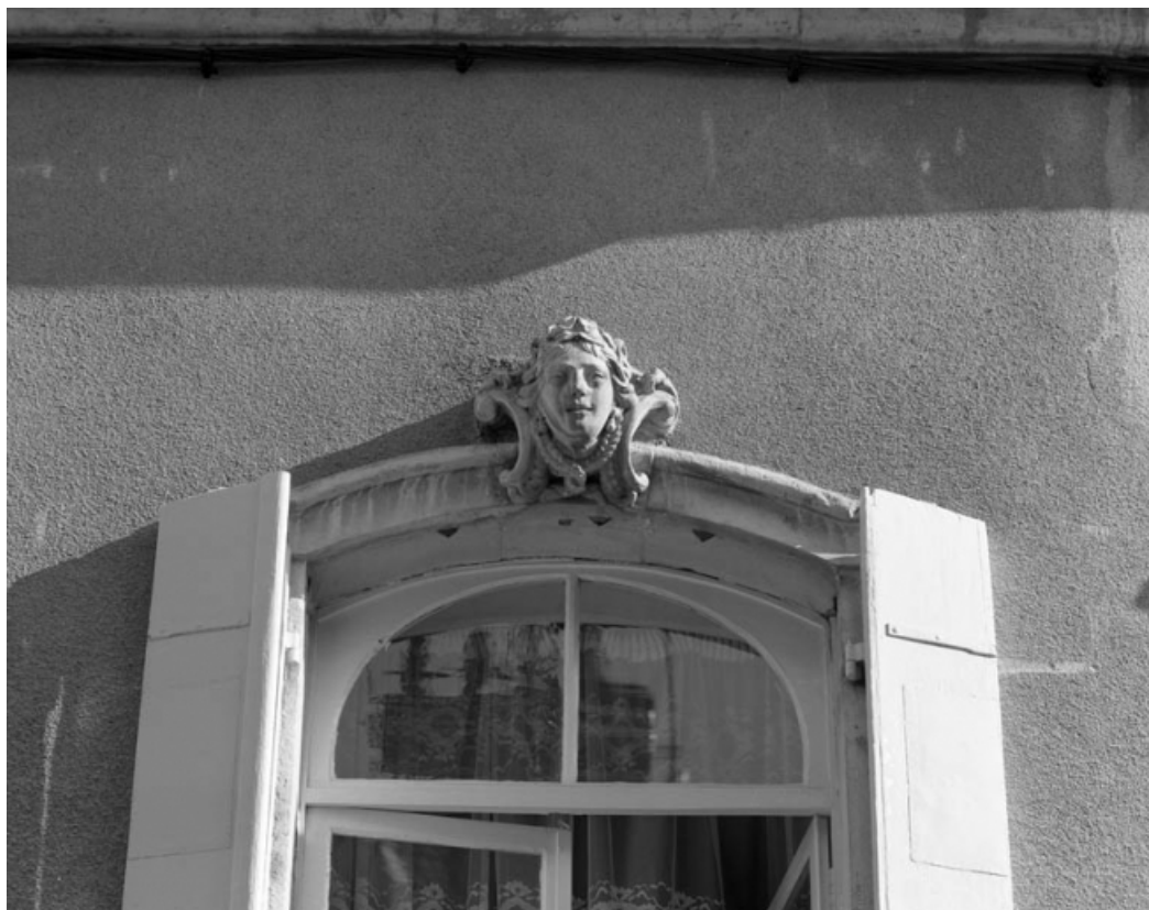
Façade antérieure : détail d'une agrafe d'une fenêtre du premier étage.
