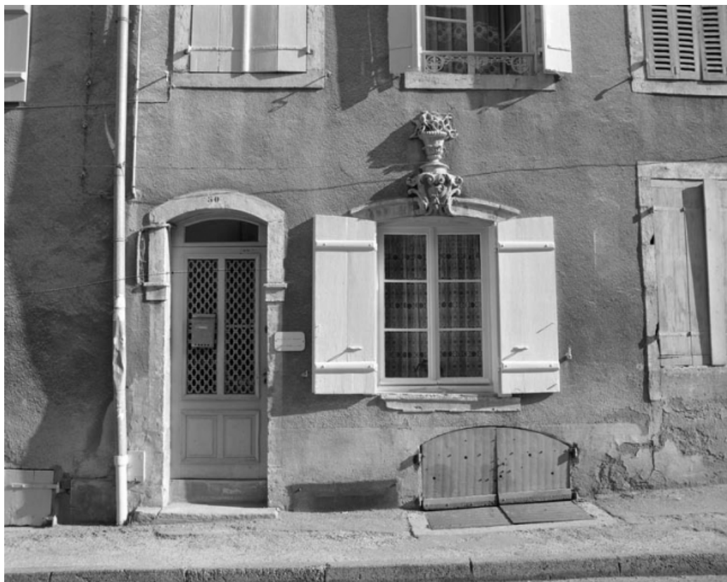
Façade antérieure : détail d'une partie du rez de chaussée.
