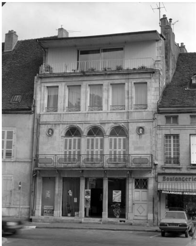
Façade antérieure de face. 70, Gray, 12 place De Gaulle
