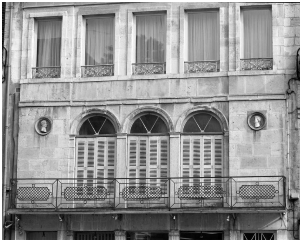
Façade antérieure : détail des baies du premier étage.
