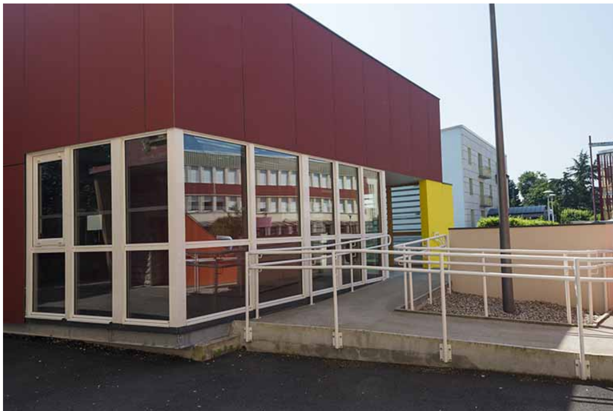
Angle nord-ouest de l'accès au centre de documentation.
