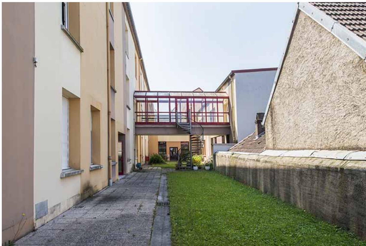
Jardin et passerelle au sud-ouest de la barre d'externat ouest.
