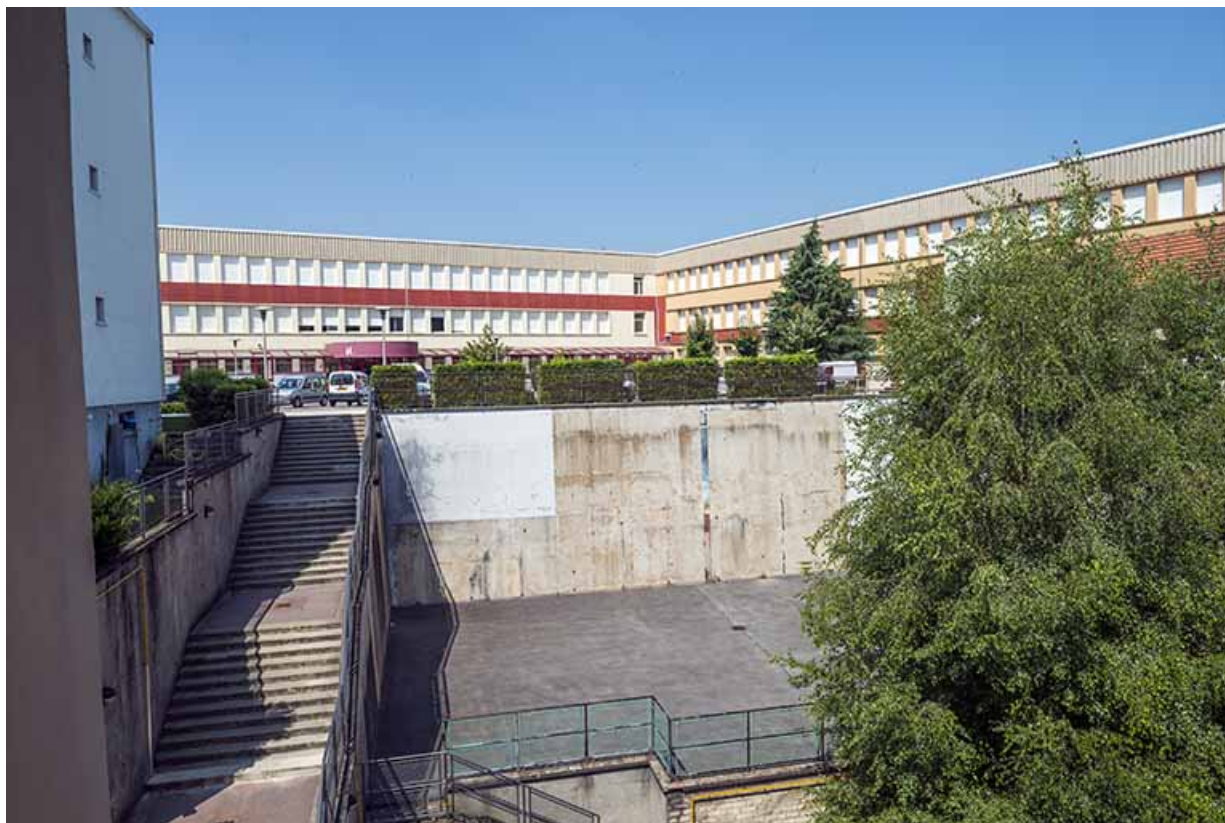
Escalier desservant la petite cour d'honneur, chaufferie, cour, angle intérieur nord ouest des bâtiments d'externat. 70, Gray Grande Rue 73
