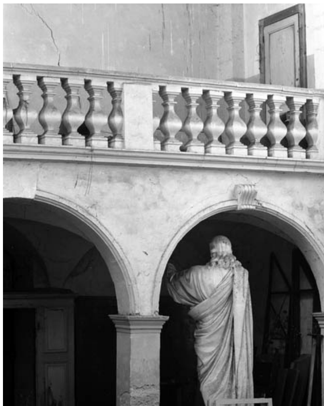
Chapelle : intérieur, détail d'un arc et de la clôture de la tribune. 70, Gray Grande Rue 73
