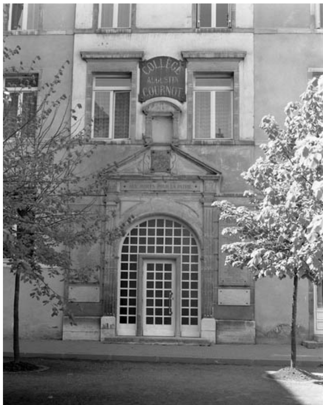
Façade antérieure du bâtiment principal : détail du portail d'entrée. 70, Gray Grande Rue 73
