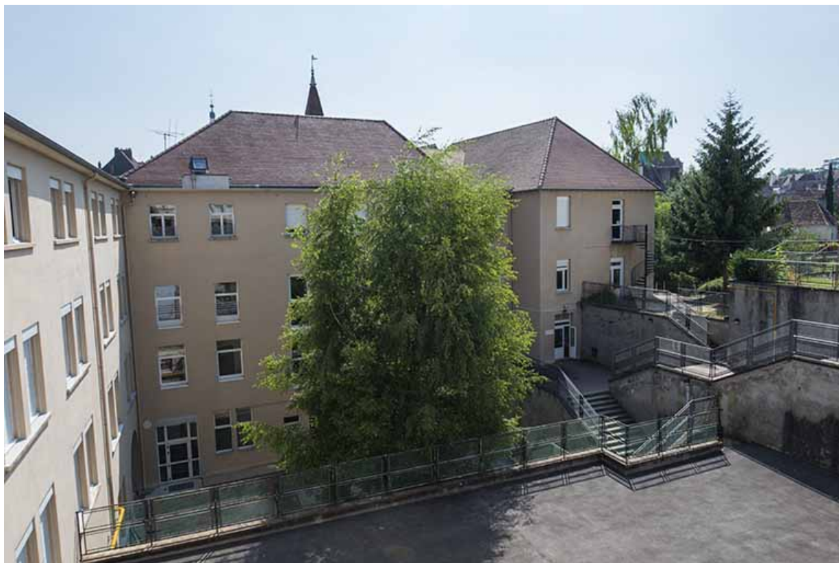
Façade postérieure est de l'ancien collège. 70, Gray Grande Rue 73
