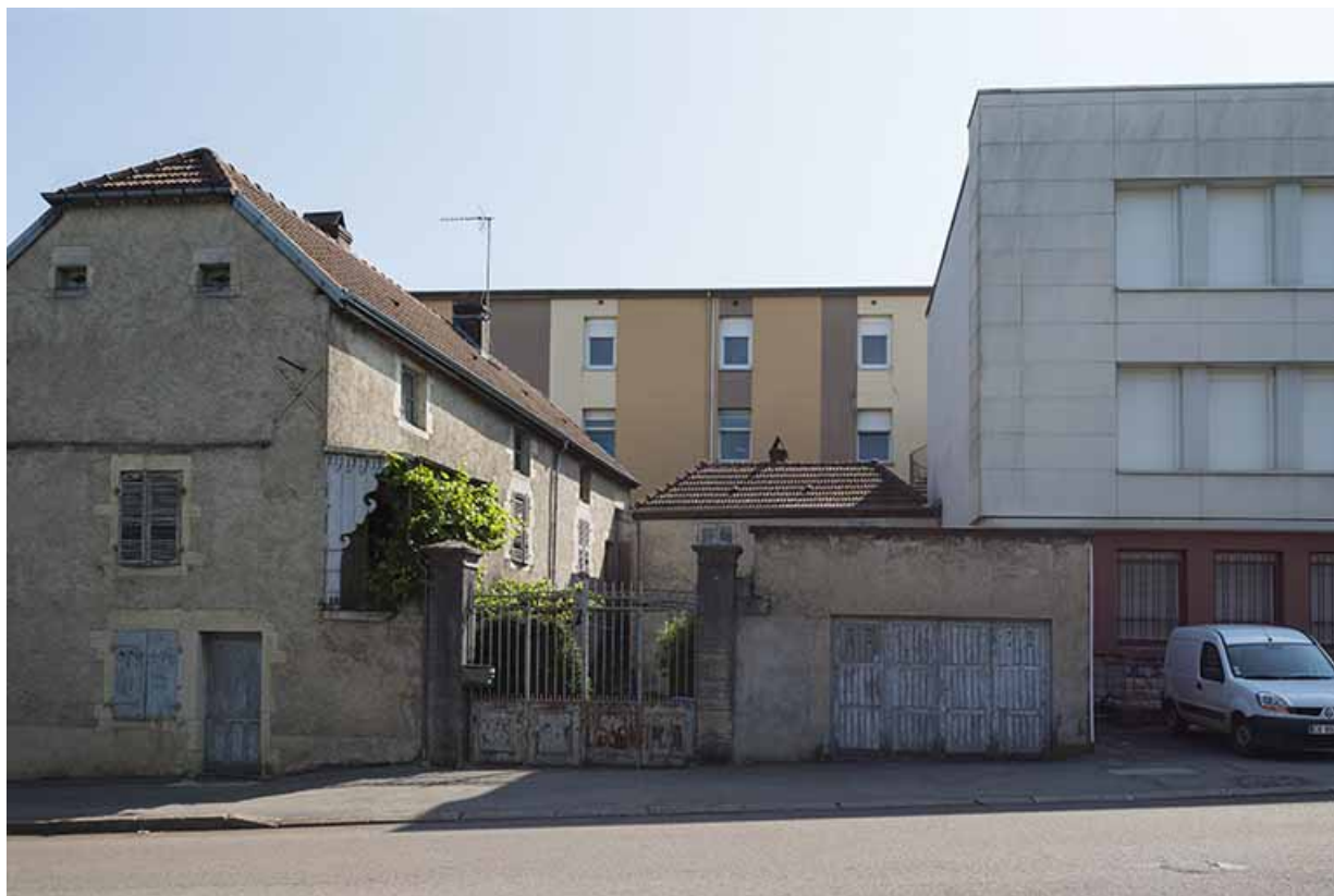
Détail de l'angle nord de la façade postérieure ouest sur la rue de l'arsenal. 70, Gray Grande Rue 73
