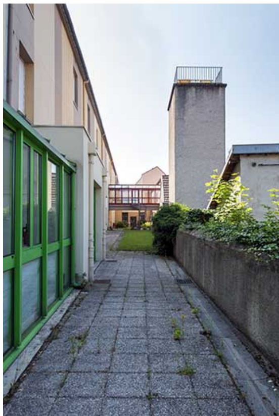
Façade postérieure ouest de la barre d'externat ouest. 70, Gray Grande Rue 73
