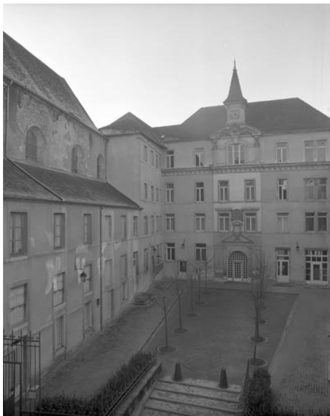
Aile gauche et façade antérieure du bâtiment principal.
