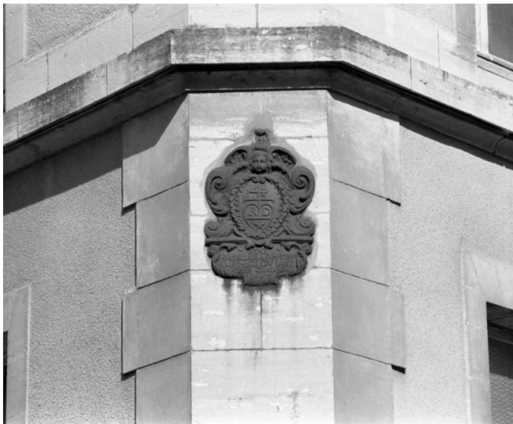
Plaque de fondation d'une classe, sur aile droite du bâtiment sur cour, datée 1667 : vue d'ensemble. 70, Gray Grande Rue 73
