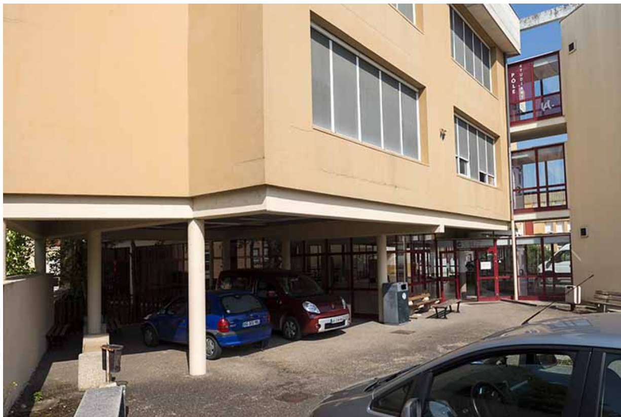
Détail du préau, au sud de l'externat ouest. 70, Gray Grande Rue 73
