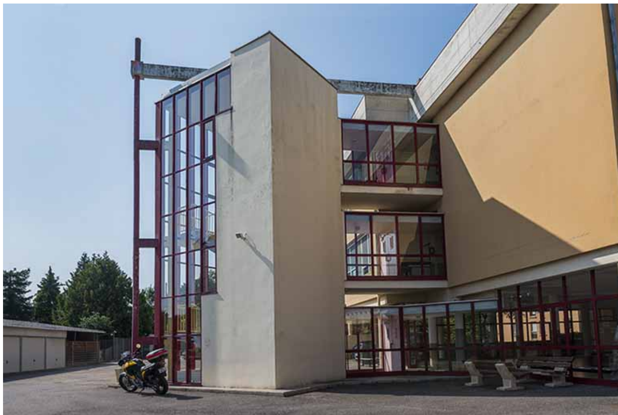
Détail de l'escalier dit le phare.
