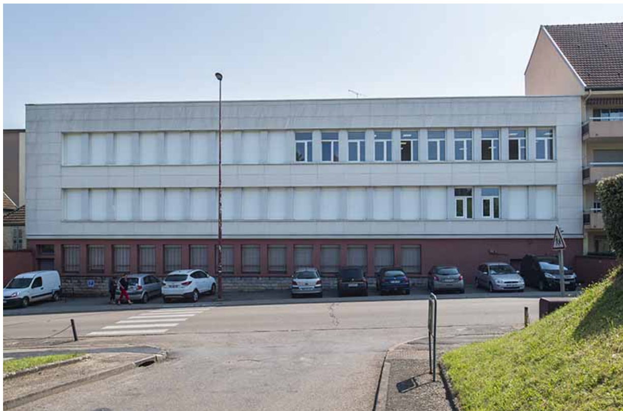
Façade postérieure ouest sur la rue de l'arsenal. 70, Gray Grande Rue 73
