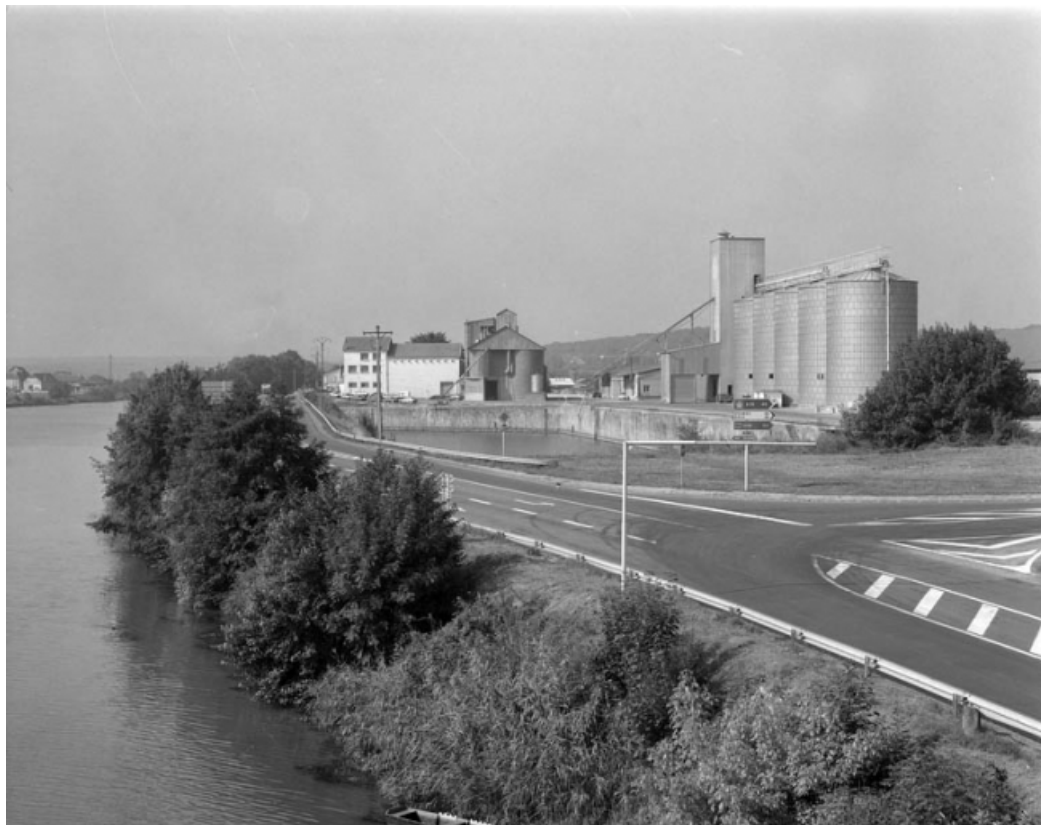
La gare fluviale et les silos : vue éloignée. 70, Gray
