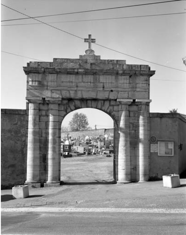
Vue du portail d'entrée : de face.
