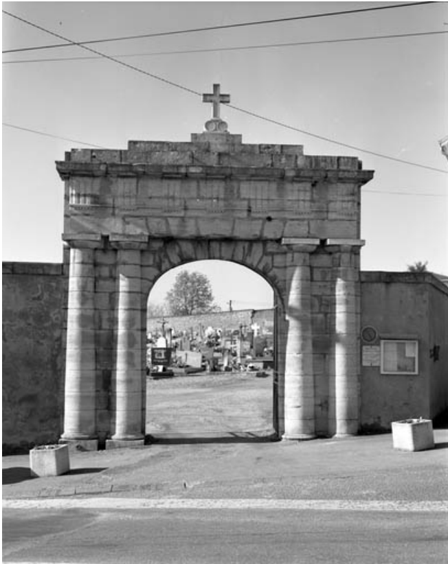
Vue du portail d'entrée : de face.
