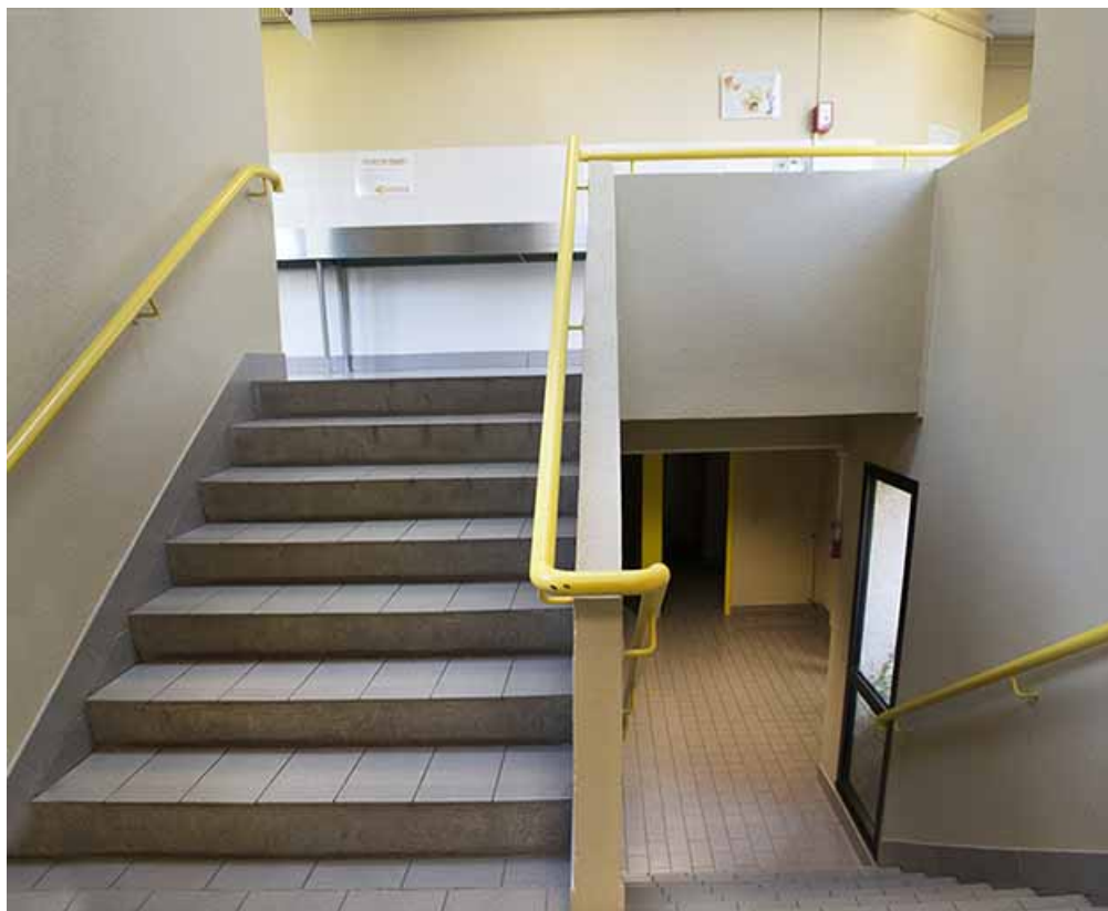
Escalier dans la cantine.
