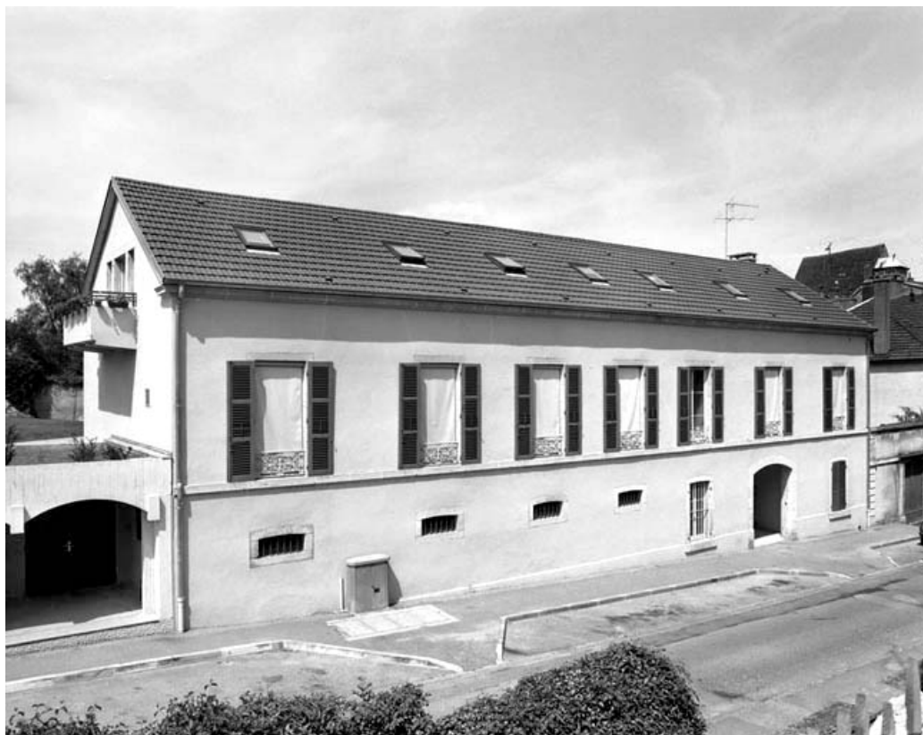
Façades antérieure et latérale gauche.
