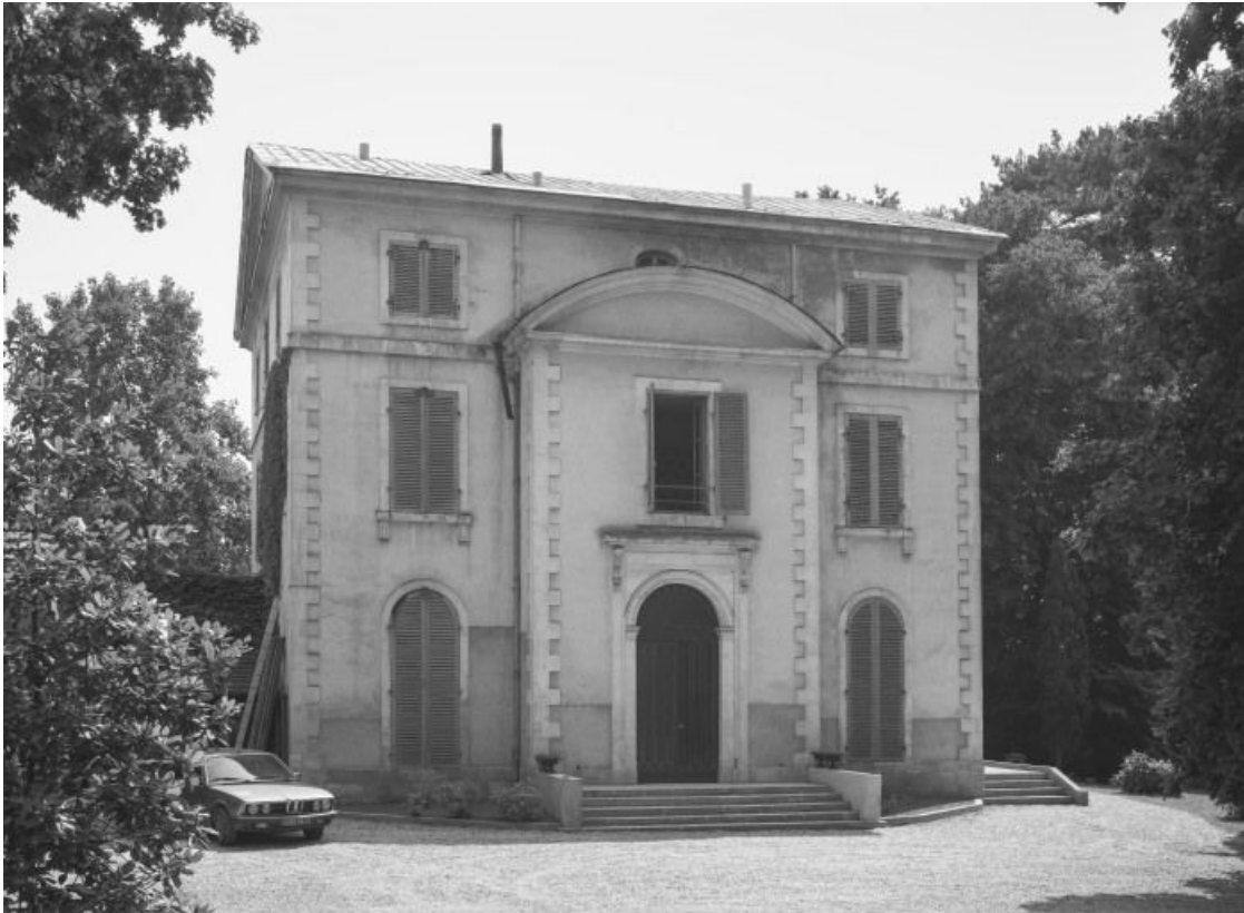
Pavillon ouest, façade antérieure.
