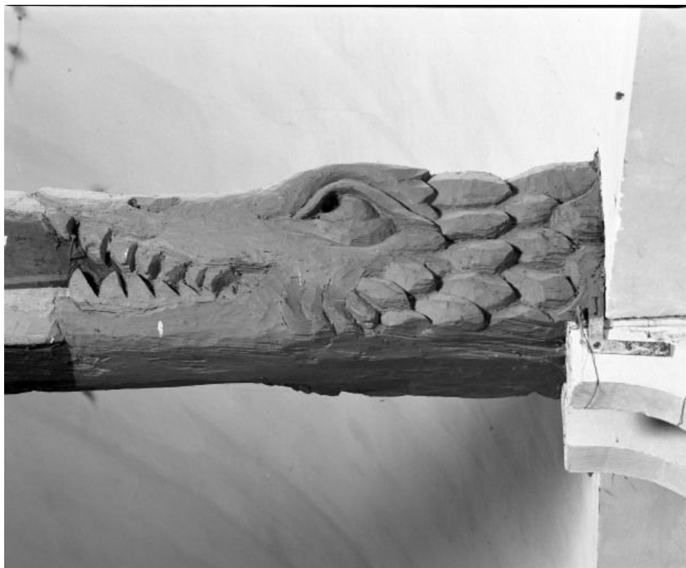
Charpente de la nef, détail du 2e entrain, revers 21, Bagnot
