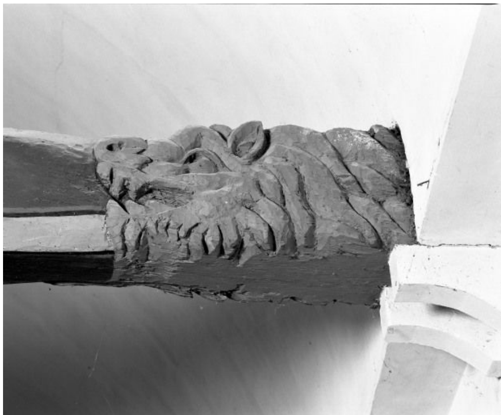
Charpente de la nef, détail du 3e entrait, revers 21, Bagnot
