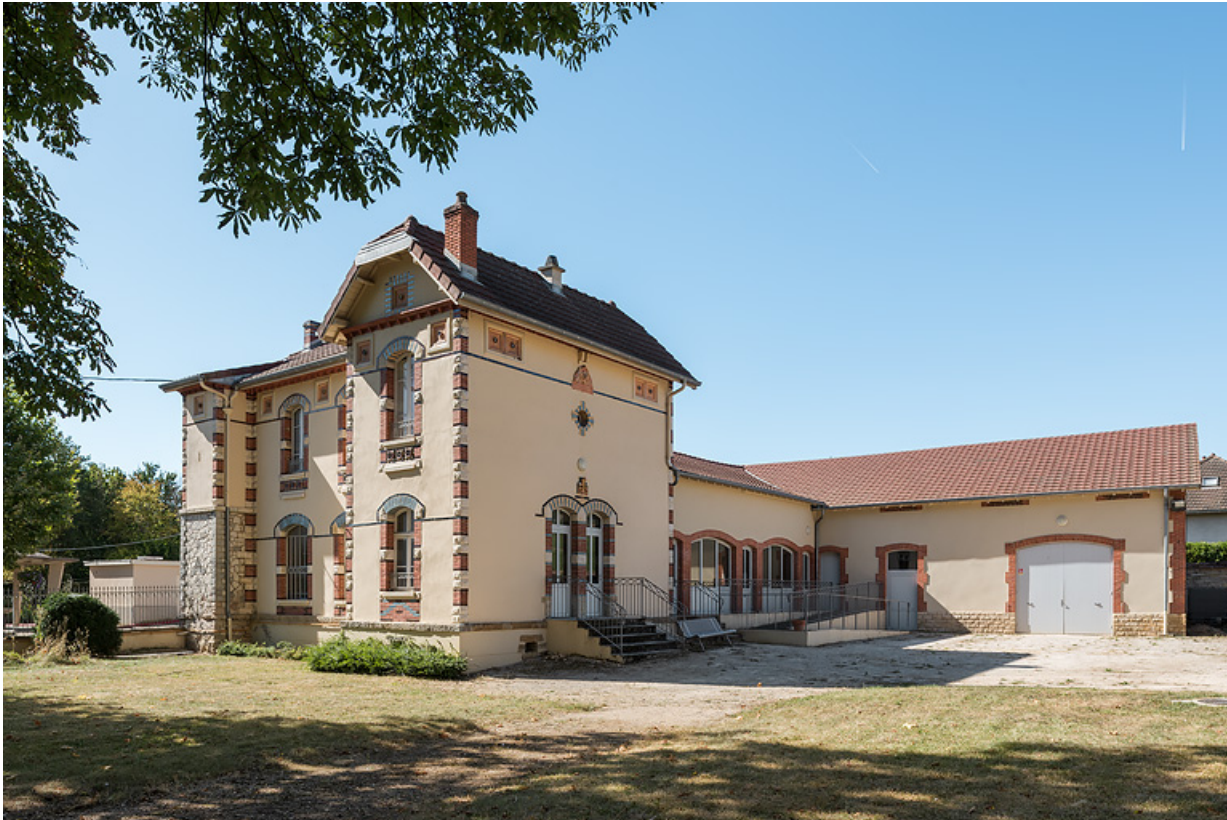
Bâtiment du forage (à gauche) avec hangar et usine d'embouteillage (à droite). 21, Santenay, 30 avenue des Sources
