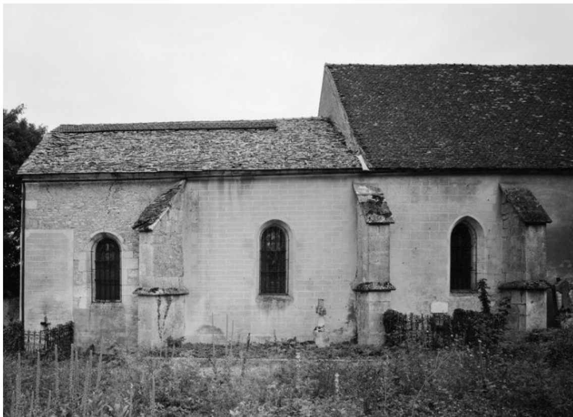
Choeur, mur gauche.
