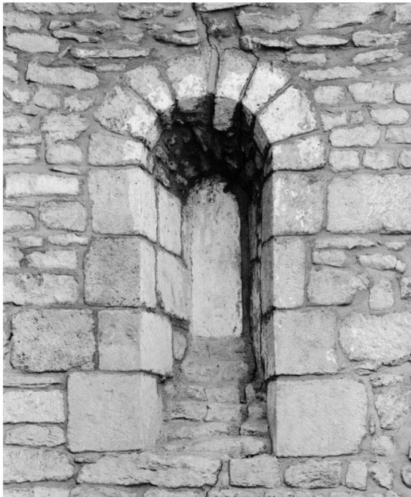
Détail d'une petite baie murée du choeur. 21, Ivry-en-Montagne
