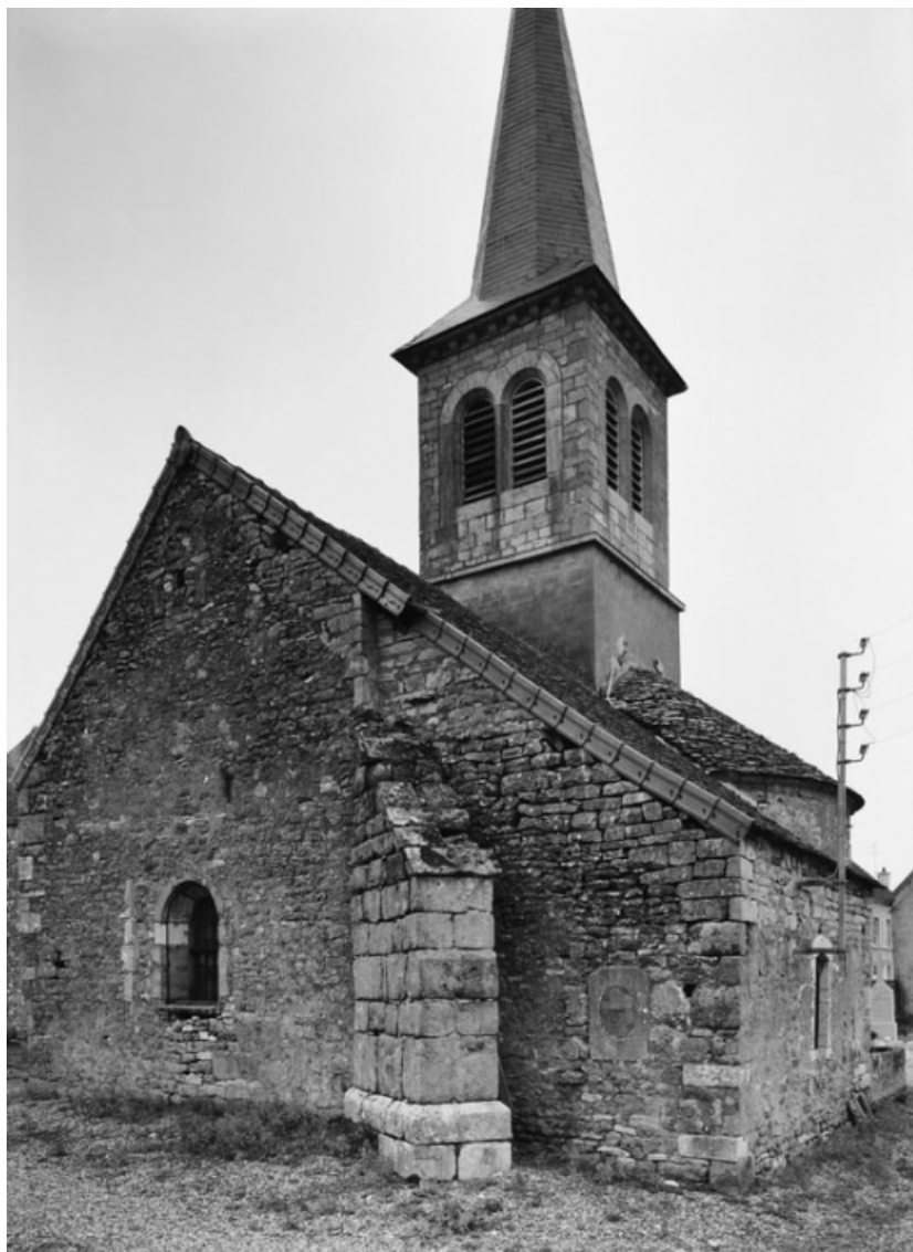
Chapelle vue de 3/4 droit. 21, Ivry-en-Montagne
