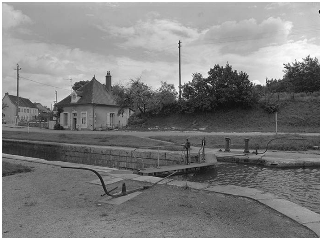
Vue du site d'écluse et de la maison éclusière en 1973.
