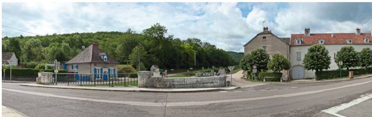
Vue du site d'écluse à gauche et de l'ancien relais de poste à droite.
