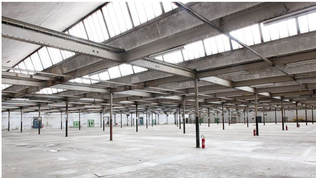
Salle de filature. Vue depuis le sud-est.
