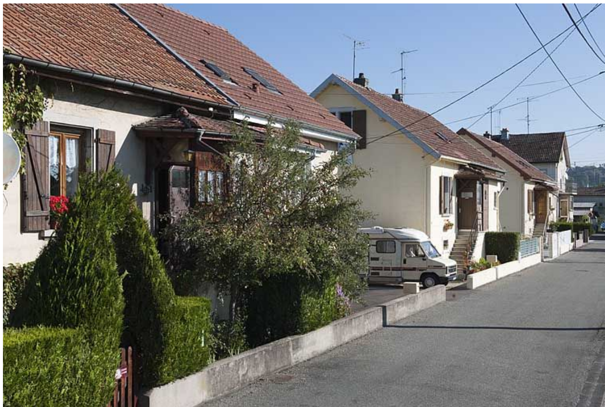
Maisons jumelées rue de Champagne. Vue depuis le sud-est.
