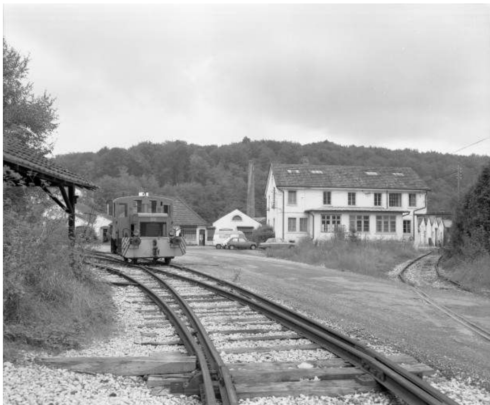
Vue d'ensemble depuis le sud-est en 1981.
