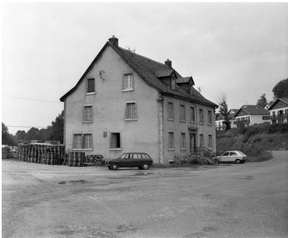
Logement, puis bâtiment des « activités sociales » en 1981.
