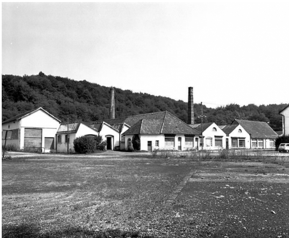
Ateliers de fabrication depuis le sud-ouest en 1981.
