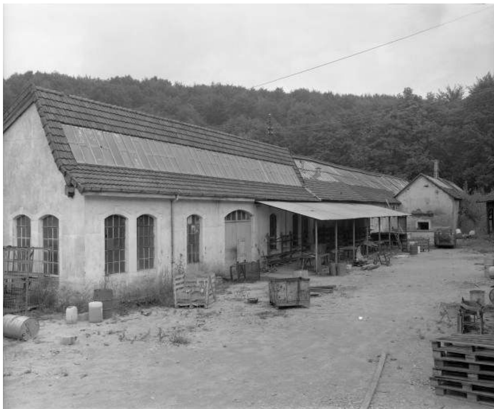
Façades est des ateliers (outillage, inox) et bâtiment des compresseurs en 1981. 25, Dampierre-les-Bois rue du 8 Mai, lieudit : la Feschotte
