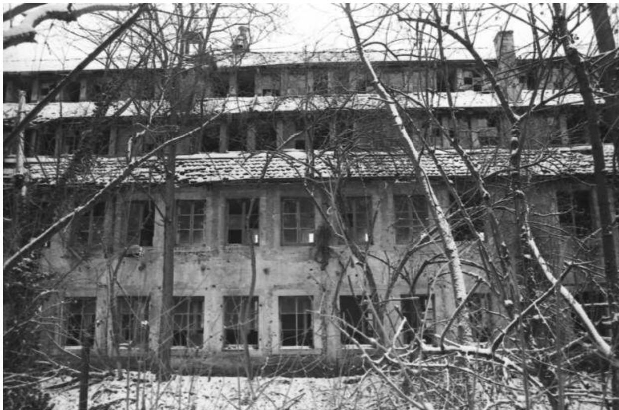
Façade occidentale de l'atelier d'horlogerie en 1979.
