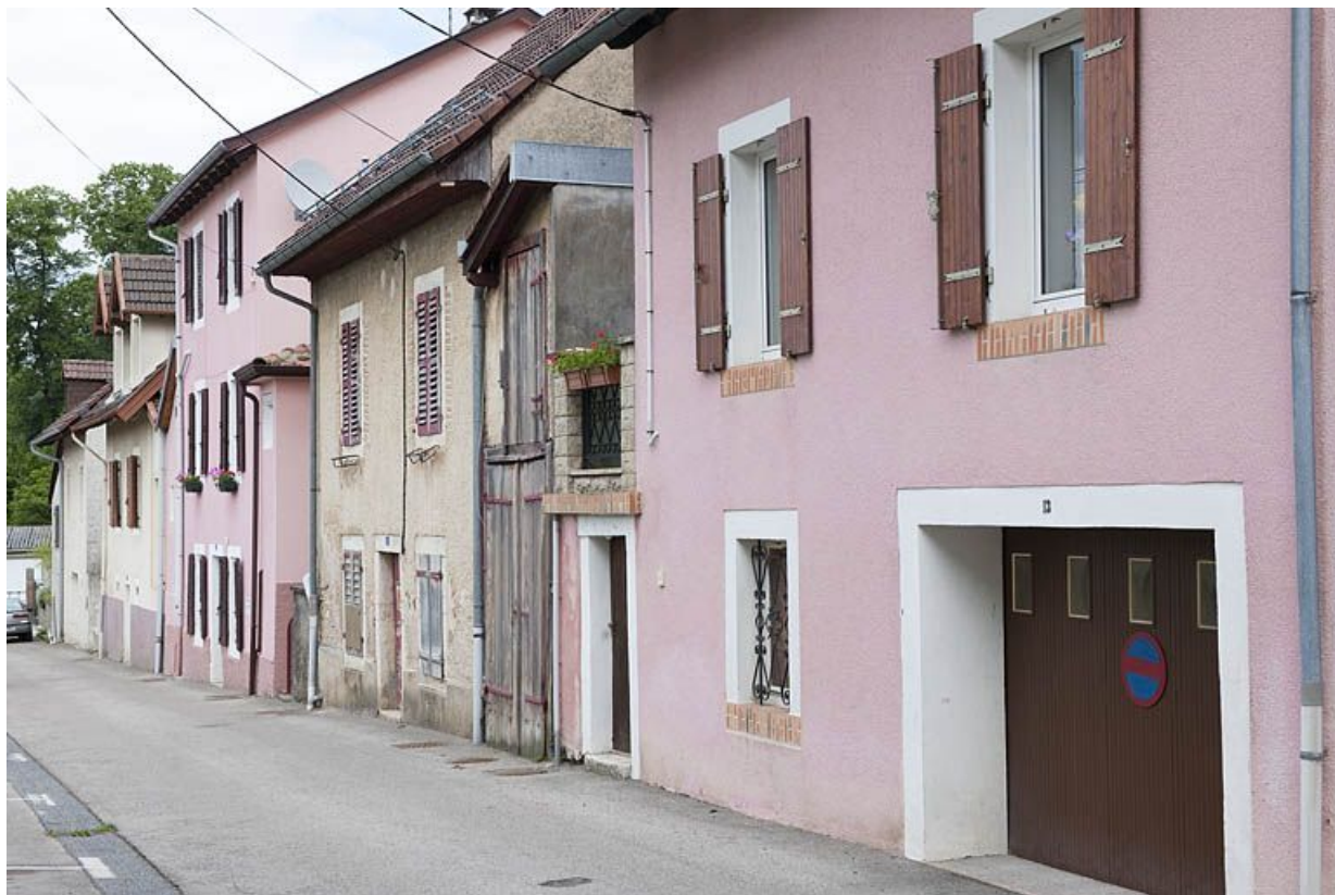
Façades ouest des logements ouvriers situés dans le bas de la rue de la Voûte. 25, Badevel rue de la Voûte
