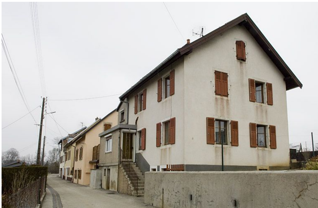
Logements situés dans le haut de la rue de la Voûte.
