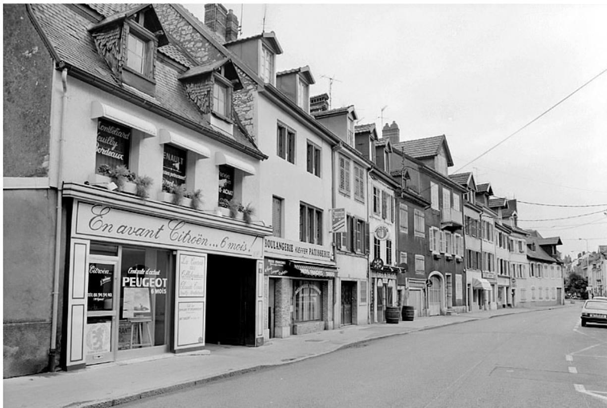
Partie septentrionale de la rue Georges-Clémenceau. 25, Montbéliard
